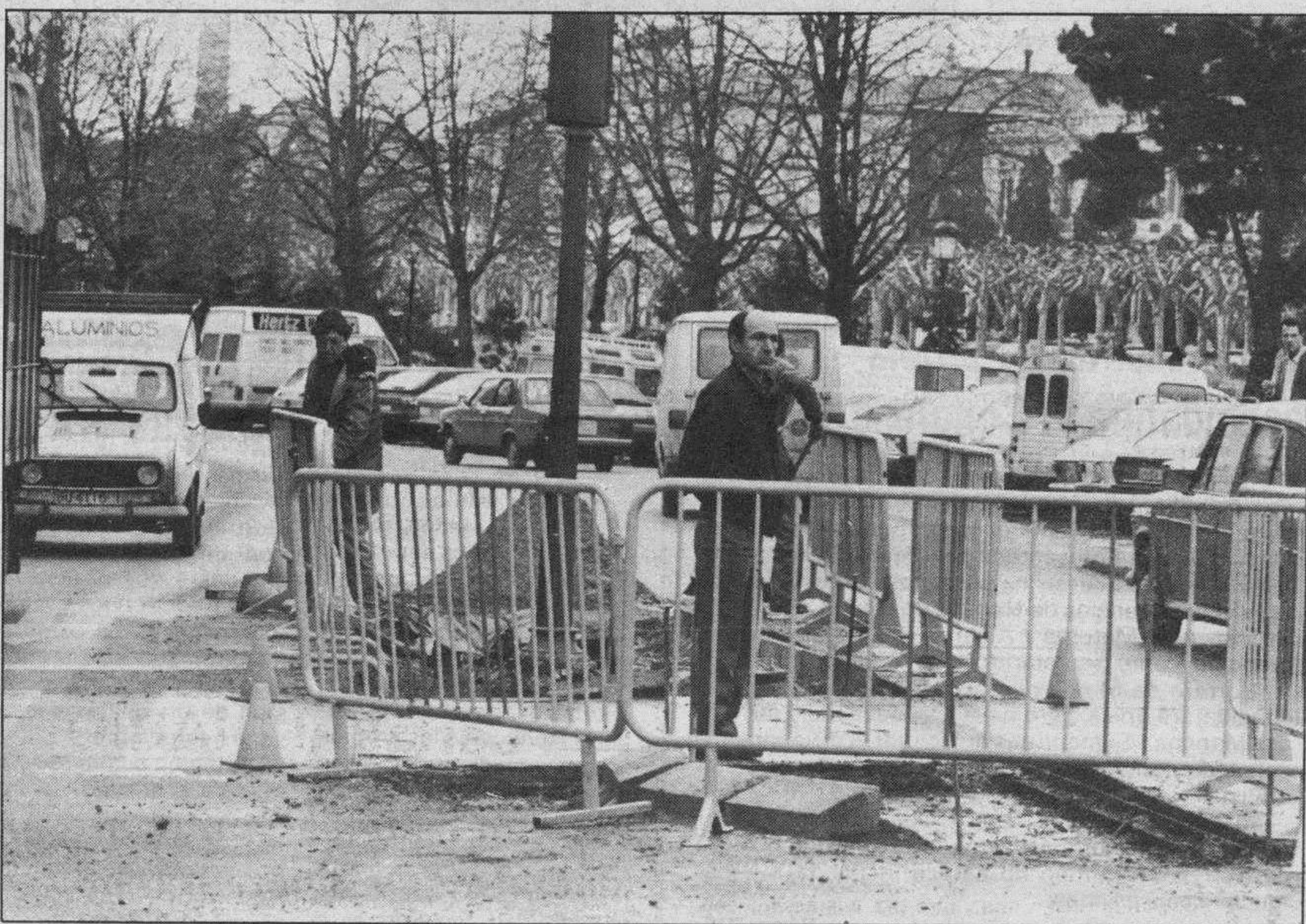
Remodelación en la Plaza de Vega. — Obras que abrigan toda esperanza se están realizando en la Plaza de Vega y en la zona de confluencia con la calle de Valladolid. Las obras de las isletas que recoge la fotografía, la ampliación de aceras, etc., parece ser el comienzo de un nuevo tiempo para esta céntrica zona. Ojalá se confirme.
