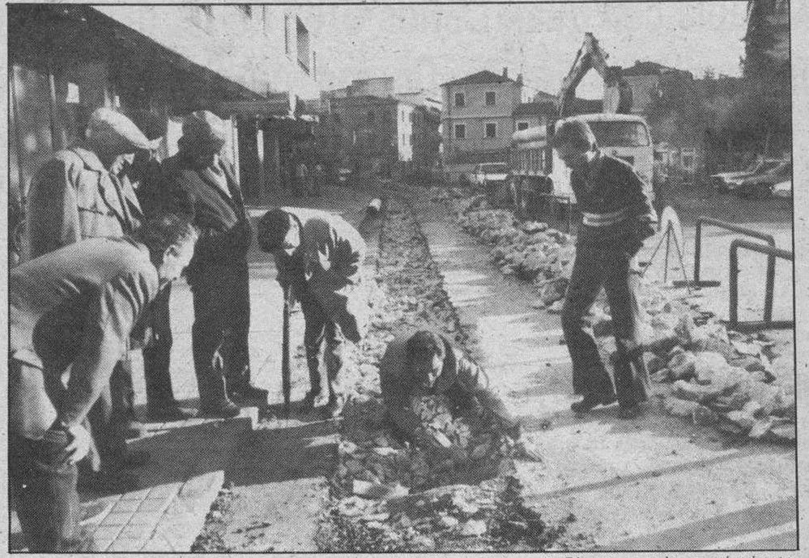
Dentro de las obras en curso, comenzaron en la Plaza Primo de Rivera, con la consiguiente curiosidad al aparecer o topar con una bodega. (Foto Florentino Lara).
