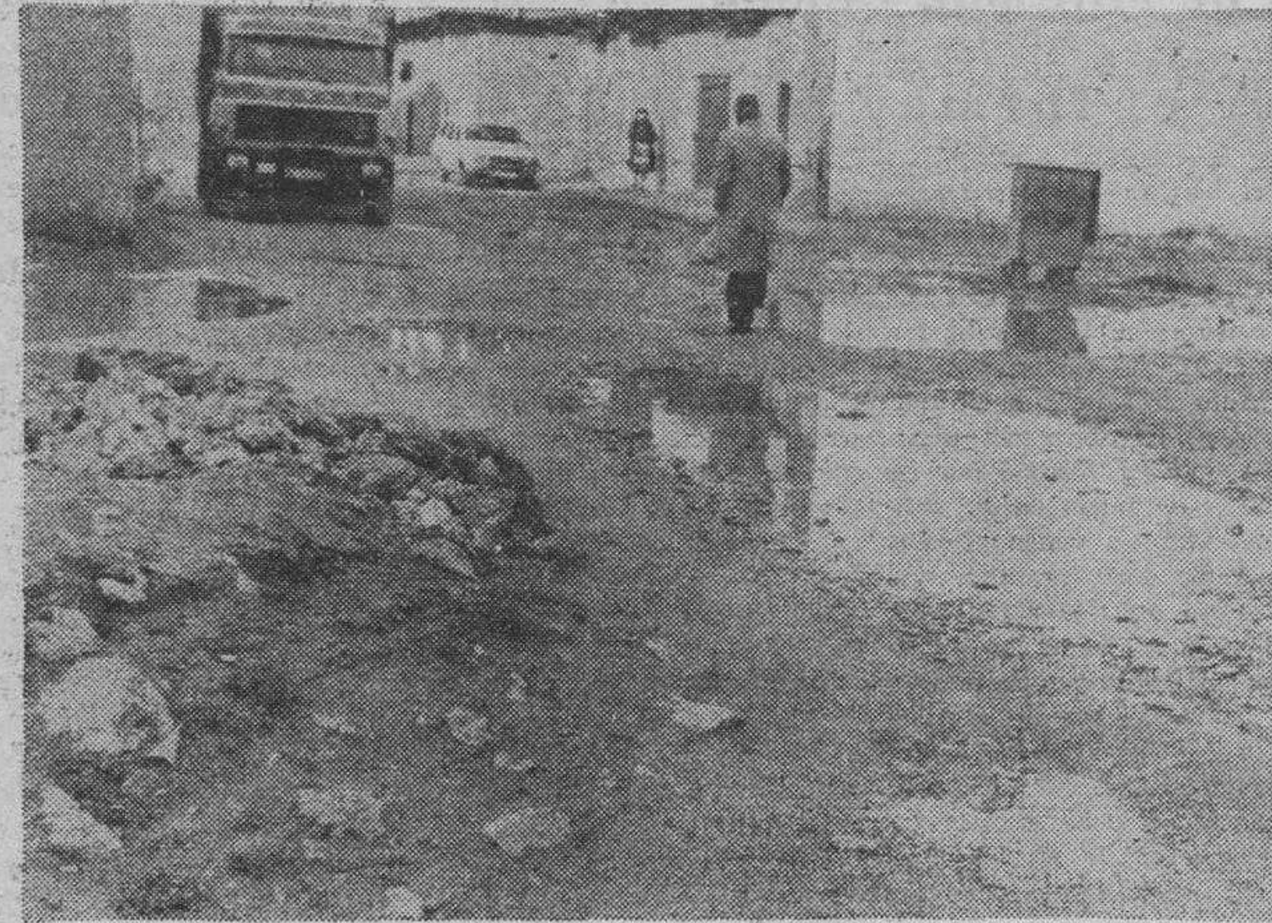
La calle de Santo Domingo podría pasar por una de las mejores de la población a no ser por este tramo, castigo de conductores y peatones. — (Foto Florentino Lara)
