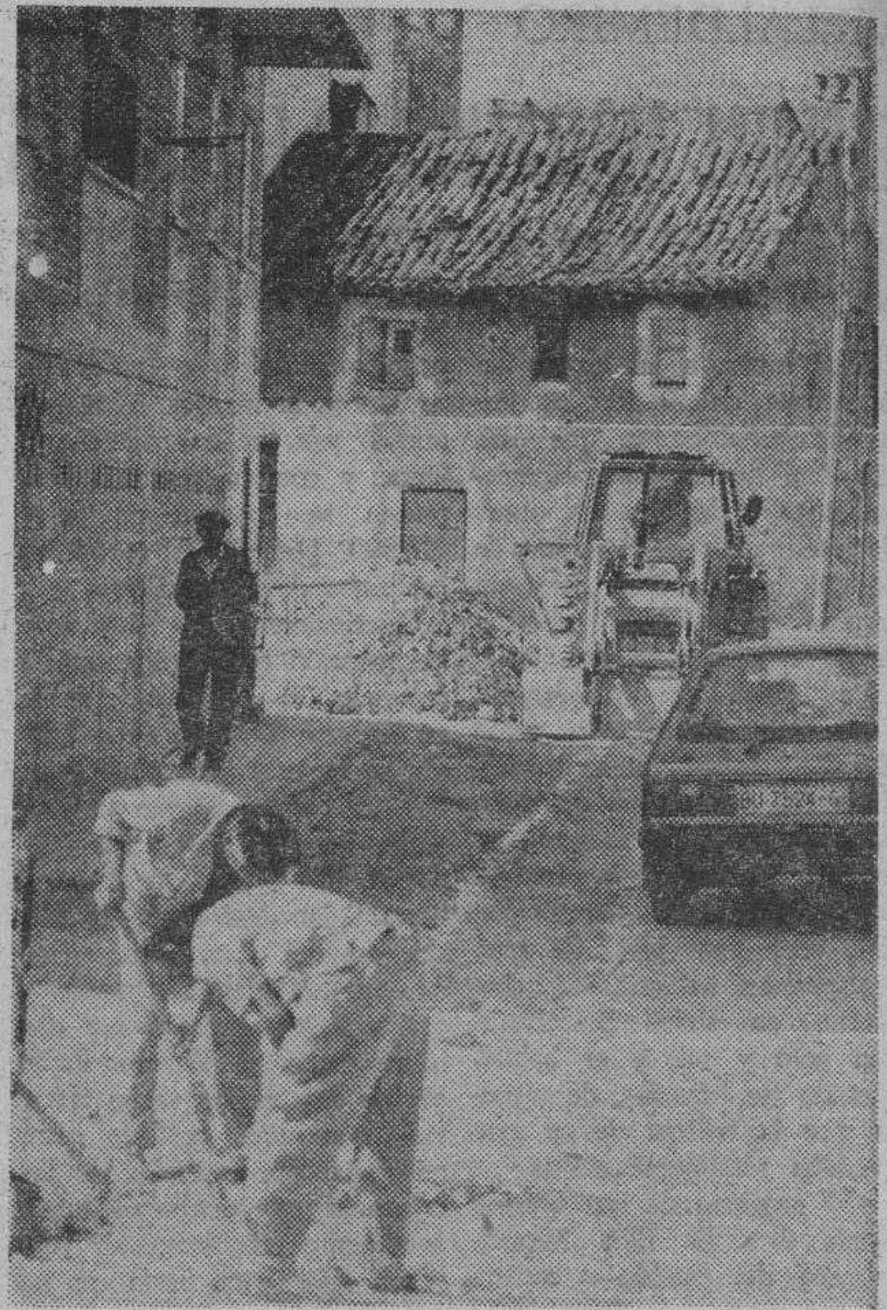
Estado actual de las obras de infraestructura del barrio de San Juan, que dieron comienzo el pasado lunes y que se prolongarán durante cinco meses.
