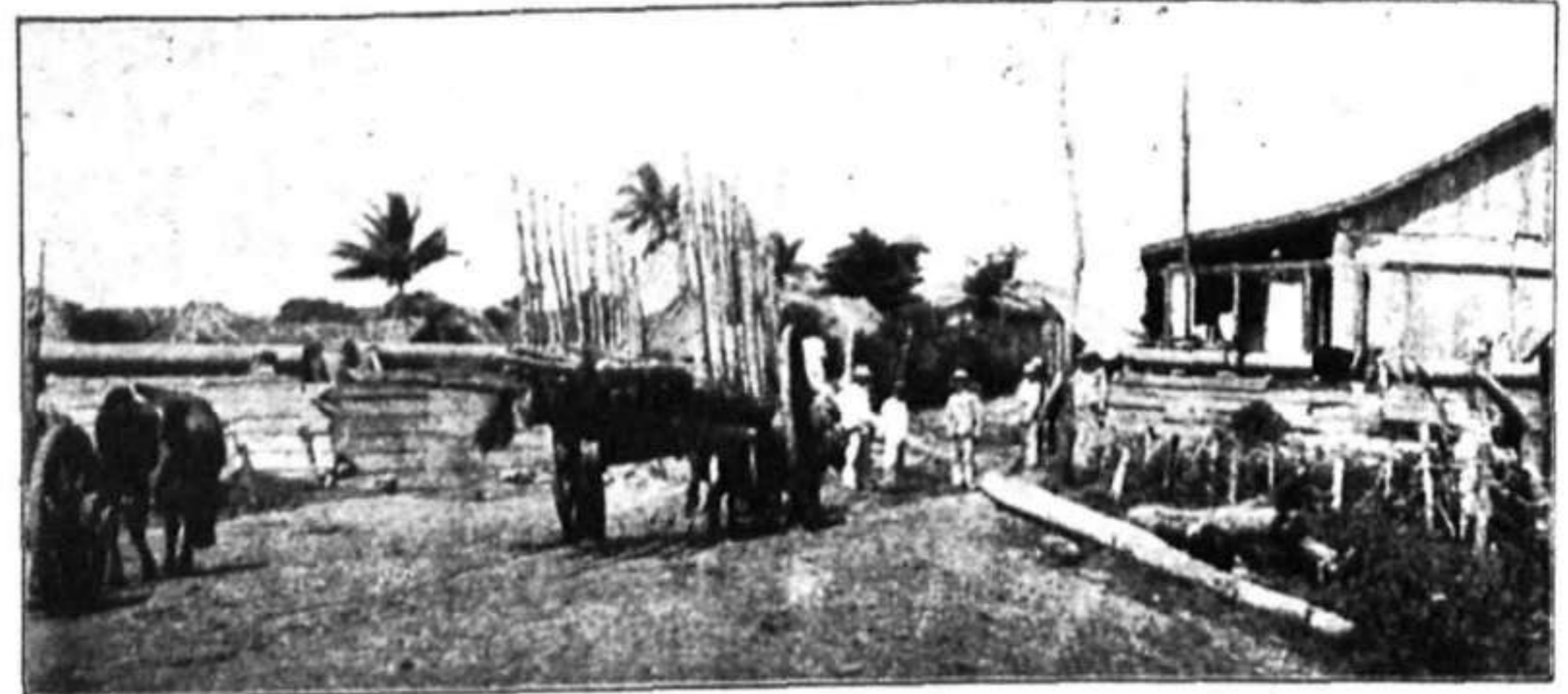
TRINCHERA DE LA ENTRADA DEL PARADERO.—PROVINCIA DE PINAR DEL RIO.—CONSOLACIÓN DEL SUR
