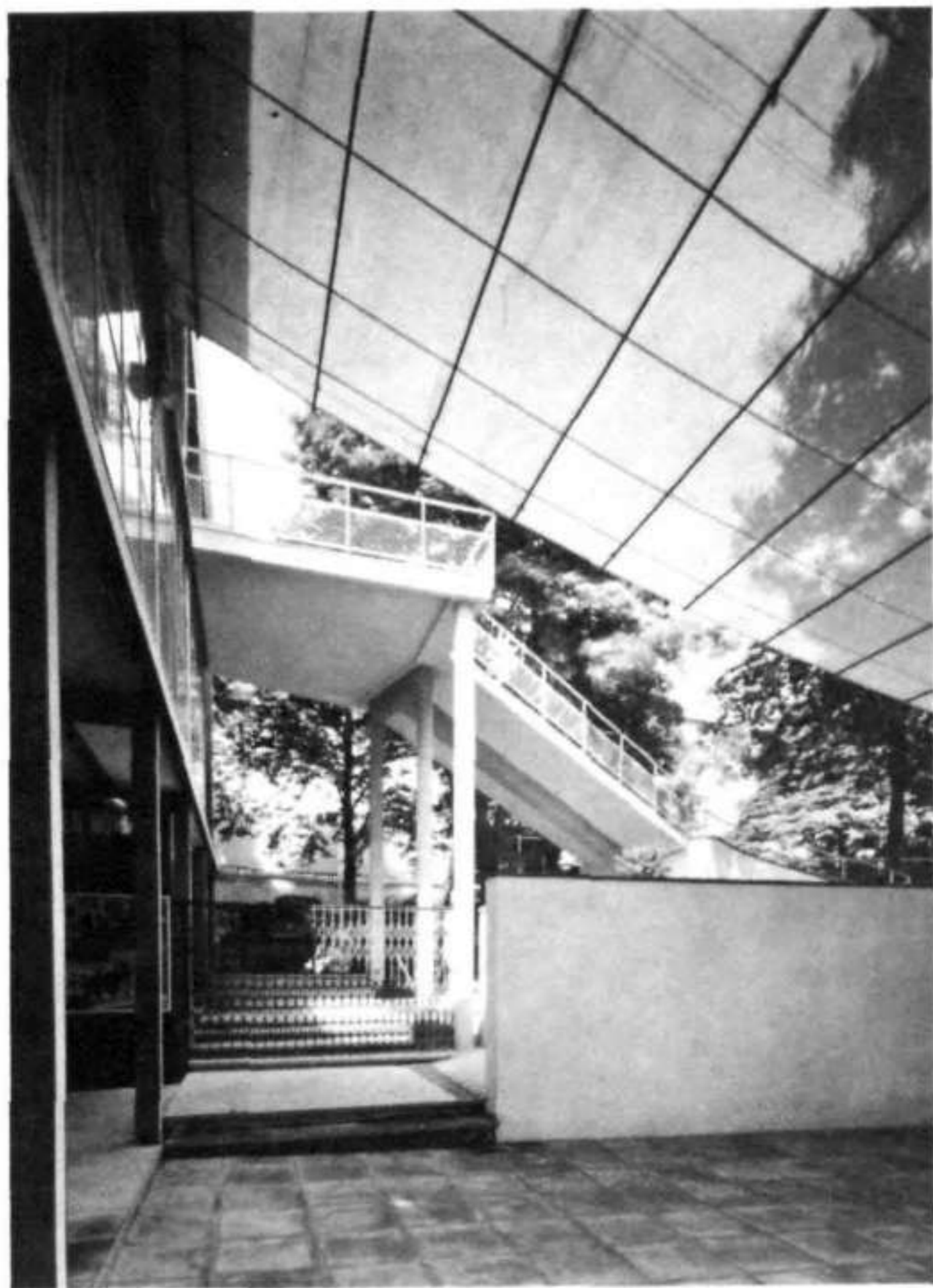
Vista lateral del patio.
