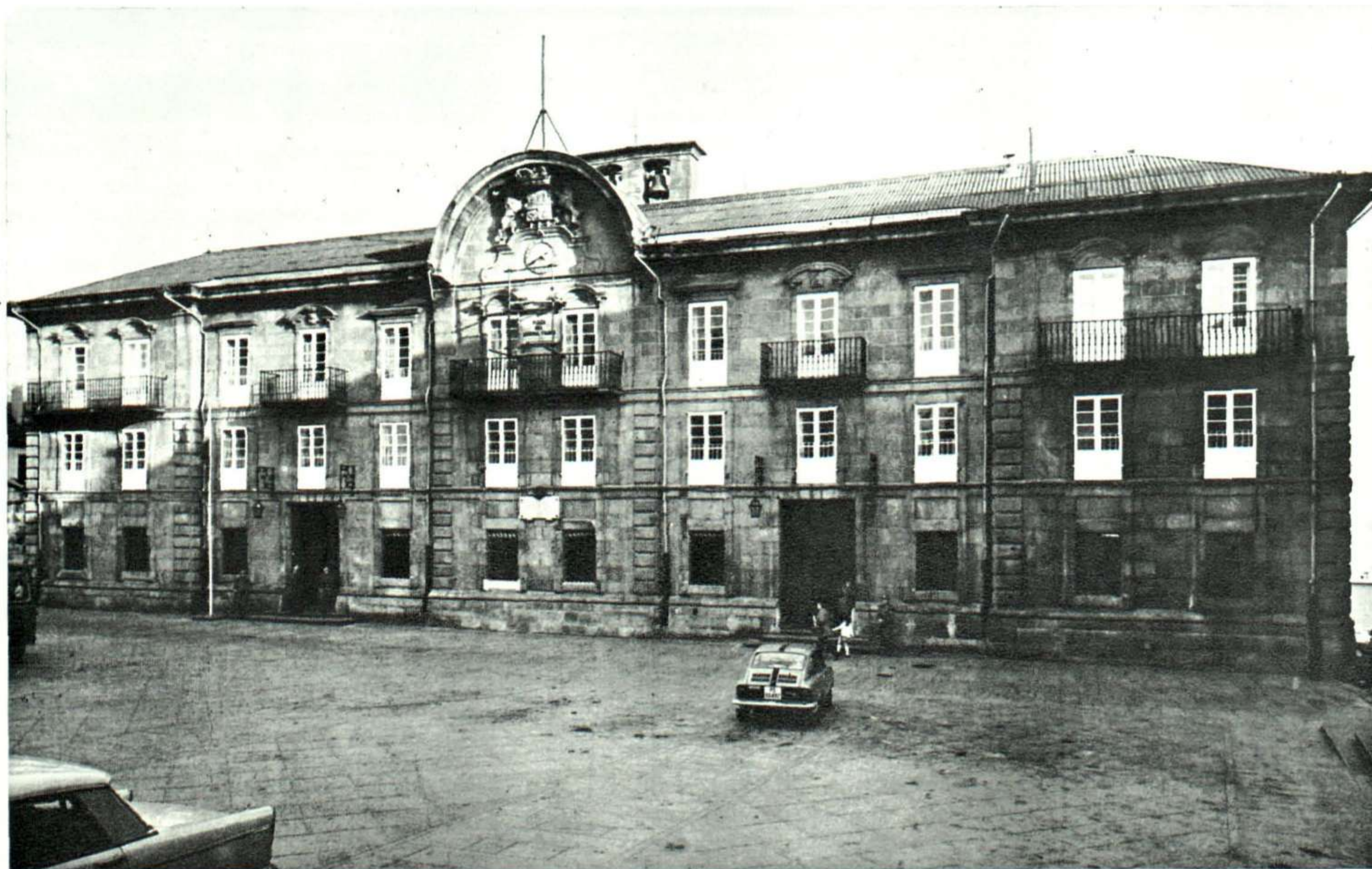
ESTADO ACTUAL DEL EDIFICIO
