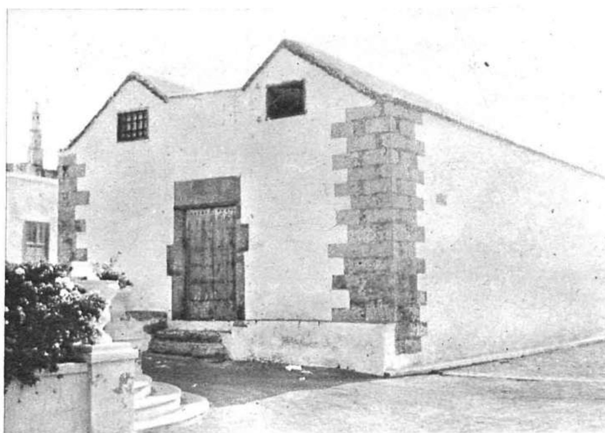
... SE HAN IMPERMEABILIZADO CUBIERTAS. EN COLABORACION CON LOS VECINOS.
