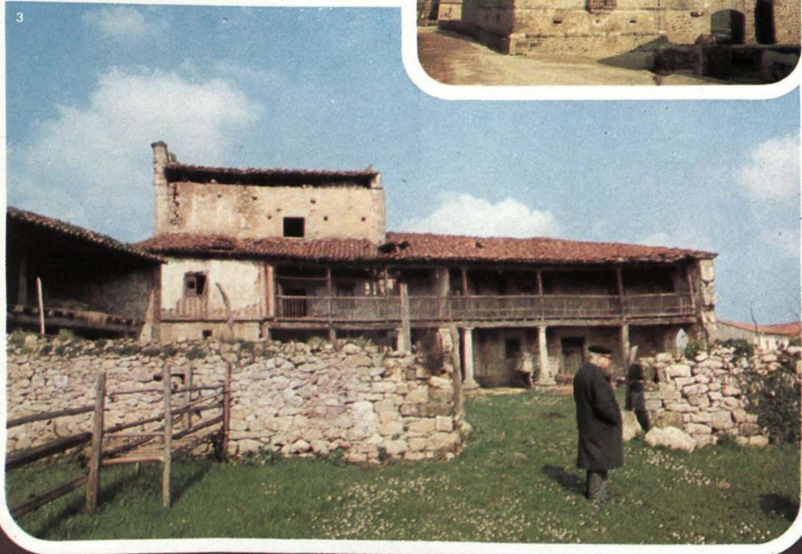
1. A esta fachada estuvo adosada una capilla de la que ya no quedaban restos cuando se comenzó la restauración general.
