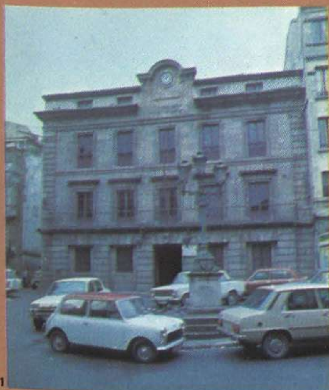
1. Instalado en el edificio del Real Consulado
