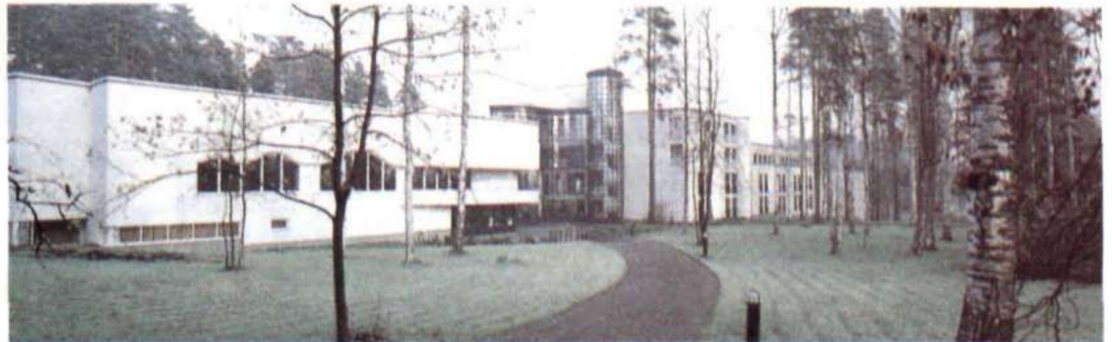
Anexo de congresos del Hotel Imatran Valtionhotelli. Imatra, 1982-85. Arquitecto: Ilmo Valjakka. Obras pertenecientes a la exposición Nuevas Formas de Finlandia.
