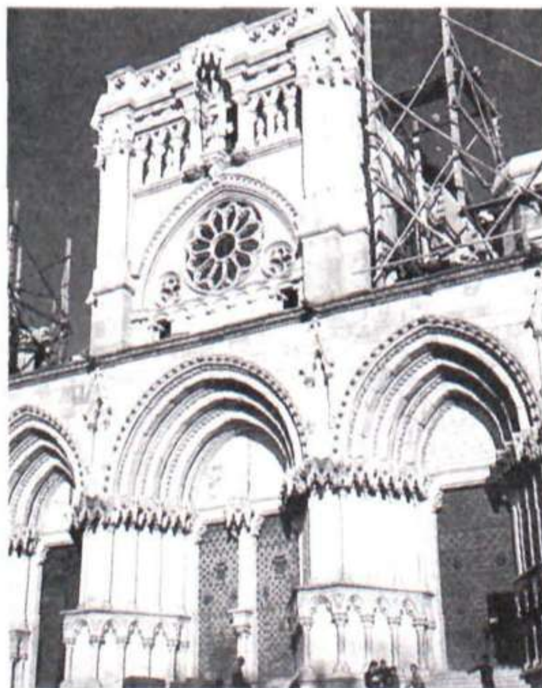
Catedral de Cuenca. Obras.
