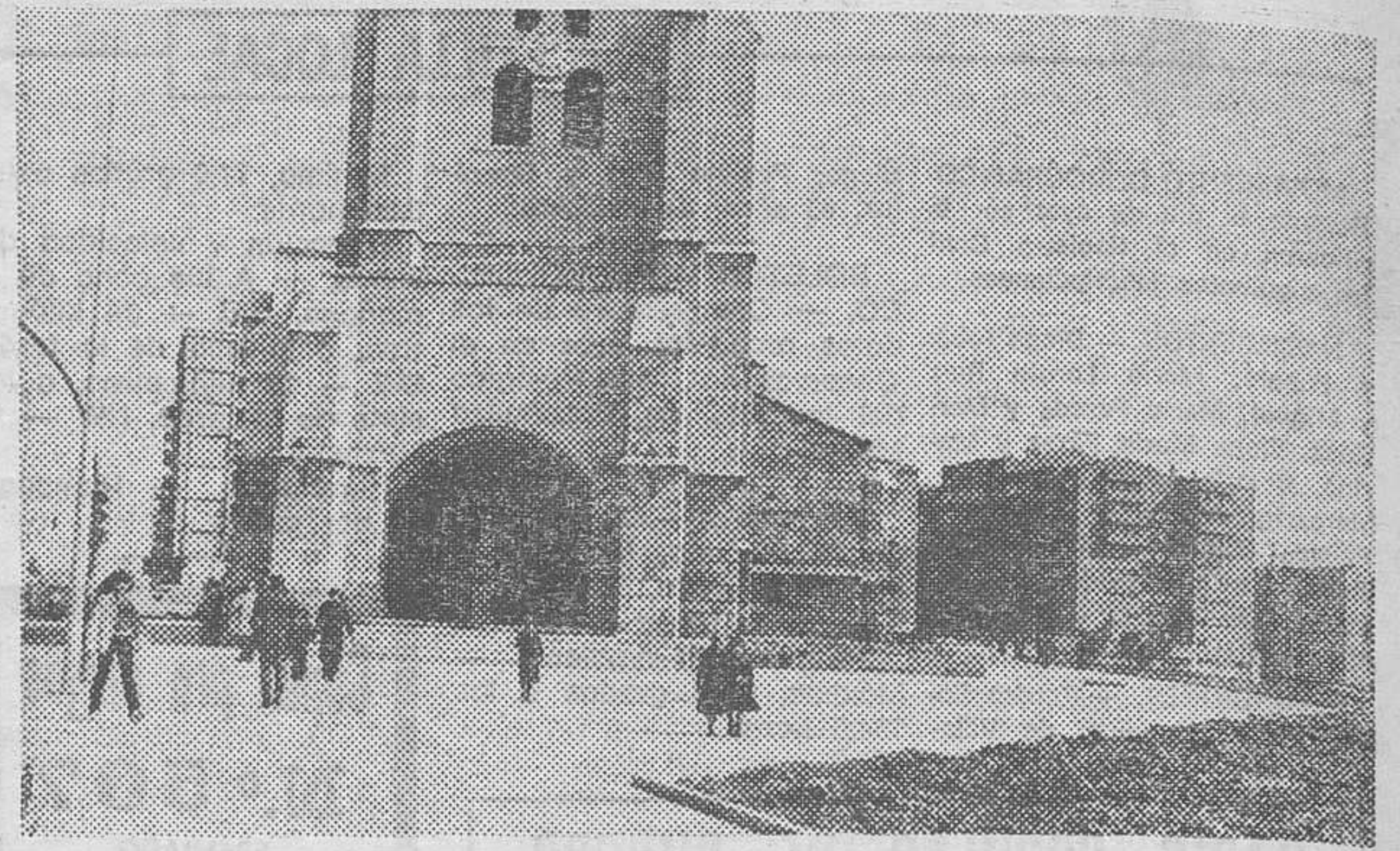
Así han quedado los alrededores de la iglesia de Nuestra Señora la Real y Antigua de Gamonal, tras las obras que se han llevado a cabo por parte del Ayuntamiento. (Foto FEDE)
