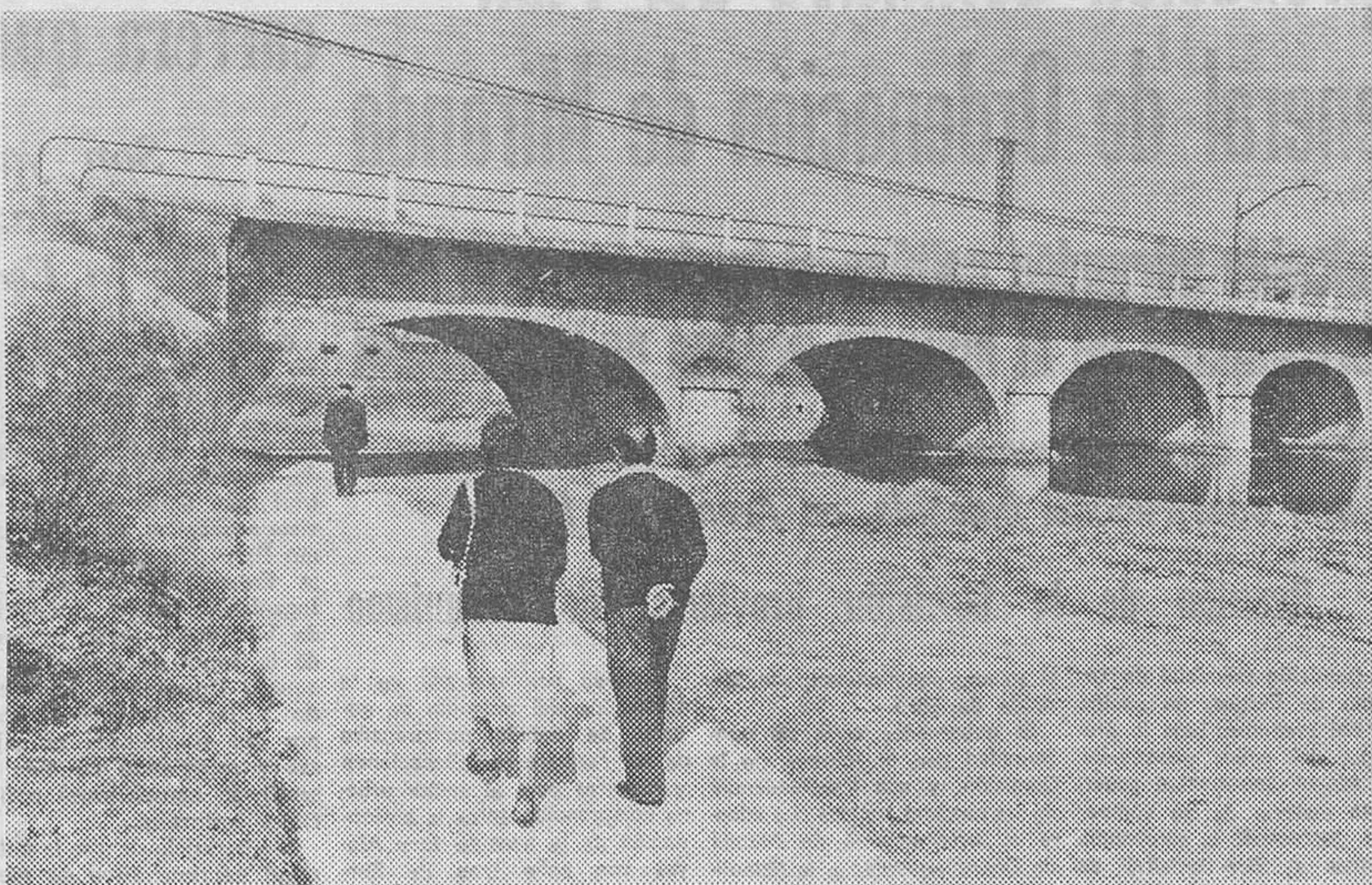
Este es el paso peatonal que ha construido la brigada de obras del Ayuntamiento en el puente de Capiscol para evitar atravesar la via férrea, «punto negro» por el elevado número de accidentes mortales que a lo largo de bastante tiempo se han registrado. El paseo peatonal y el puente elevado no justifican ya, en modo alguno, invadir el paso del tren. — (Foto FEDE).
