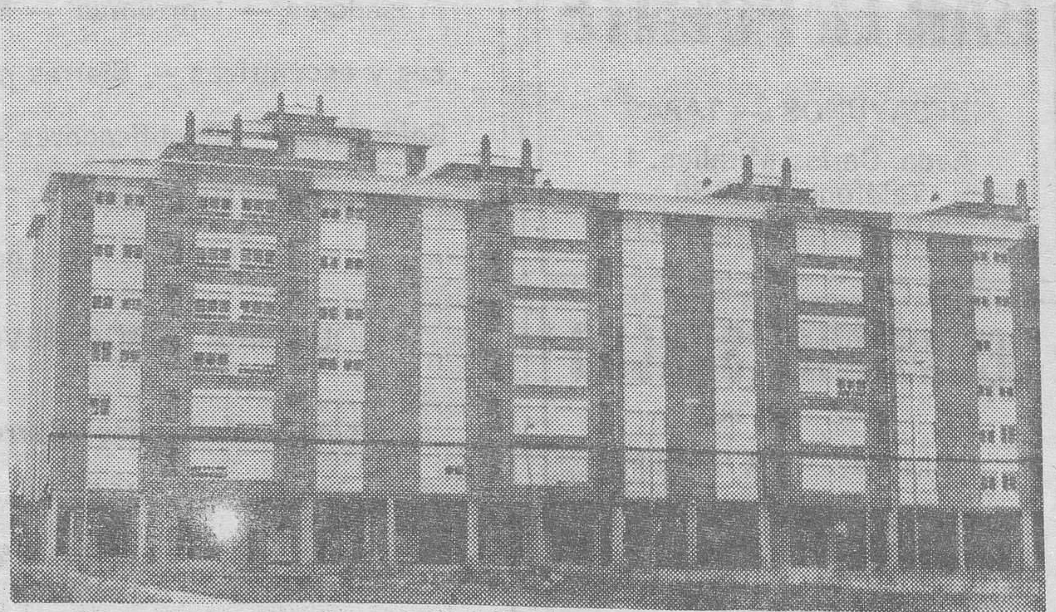
Grupo de modernos bloques de viviendas en Aranda.
