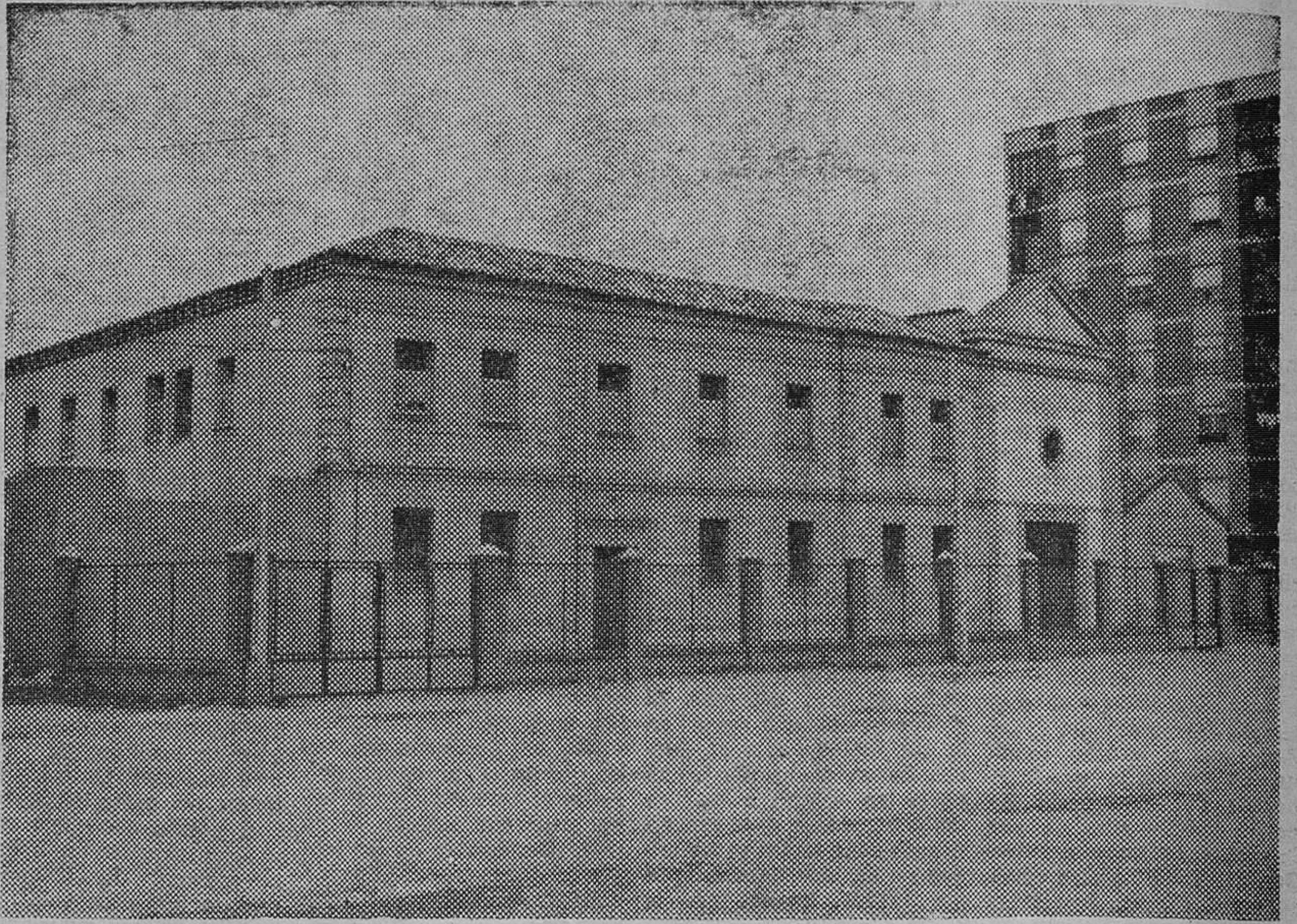
Fachada del monasterio e iglesia de MM. Bernardas de Aranda de Duero (Burgos).
