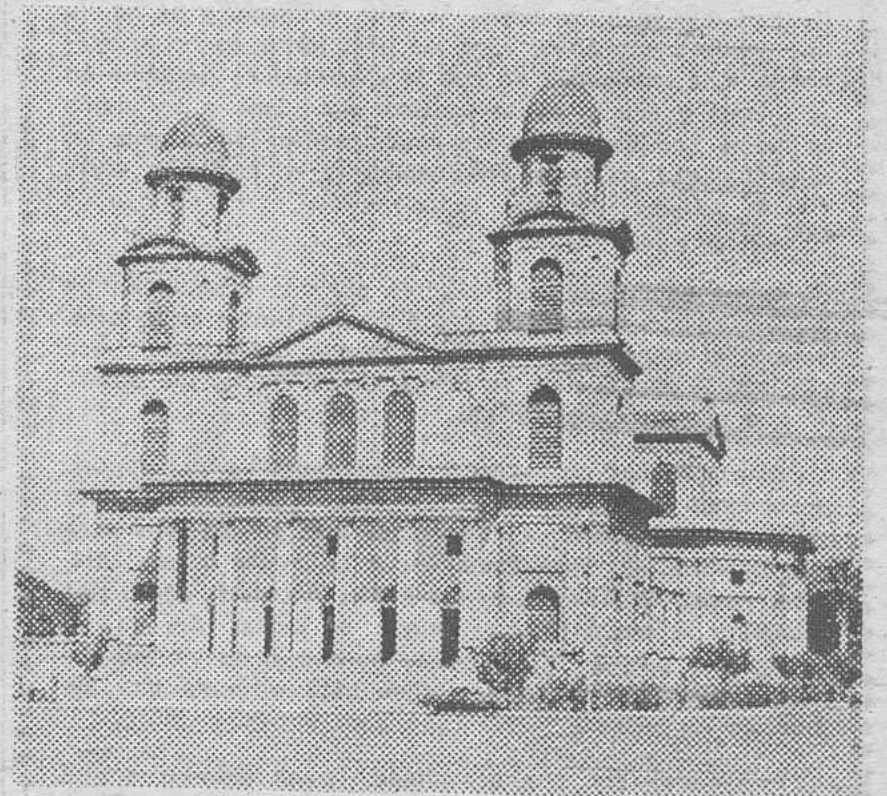
La Catedral de Managua, erigida en 1940 y que sustituyó a la primitiva, destruida por otro violento seísmo en 1931. En el terremoto de la madrugada de ayer, el templo catedralicio también ha sufrido graves daños.
