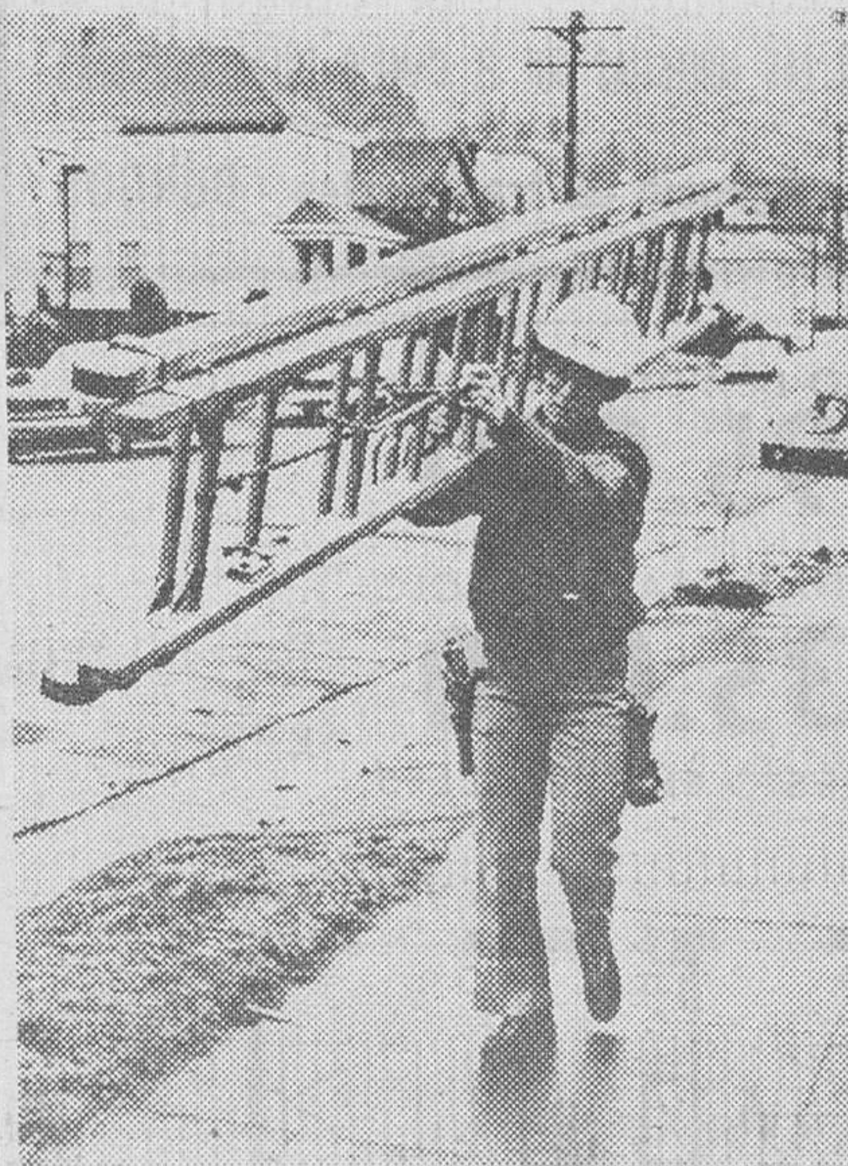
Portland (Oregón). — Patty Jo Watson, de 22 años de edad, es la primera mujer que trabaja para la Pacific Northwest Bell Company, de teléfonos, como reparadora de instalaciones. Con su escalera de mano, todos los días realiza sus rondas por esta localidad. — (Foto CIFRA GRAFICA).
