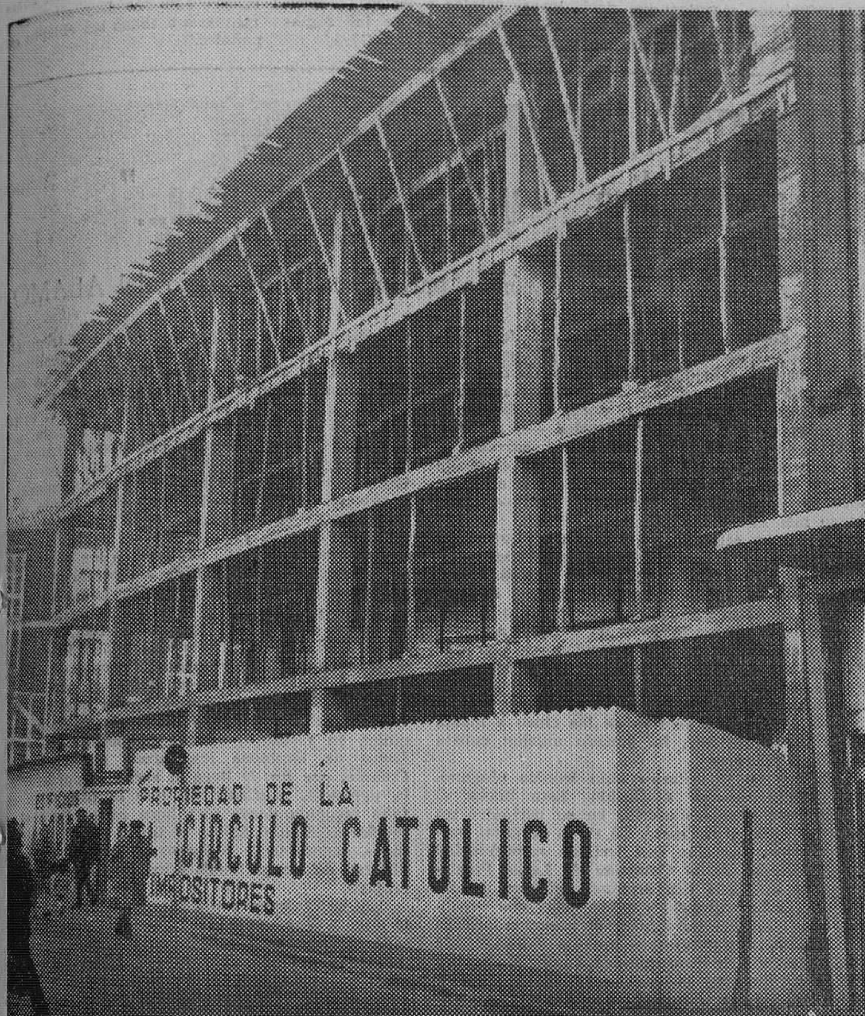
PERSPECTIVA QUE OFRECE EL CONJUNTO DE VIVIENDAS «SAN PABLO» CONSTRUIDO POR LA CAJA DE AHORROS DEL CIRCULO, DESDE LA CALLE DE MIRANDA.
