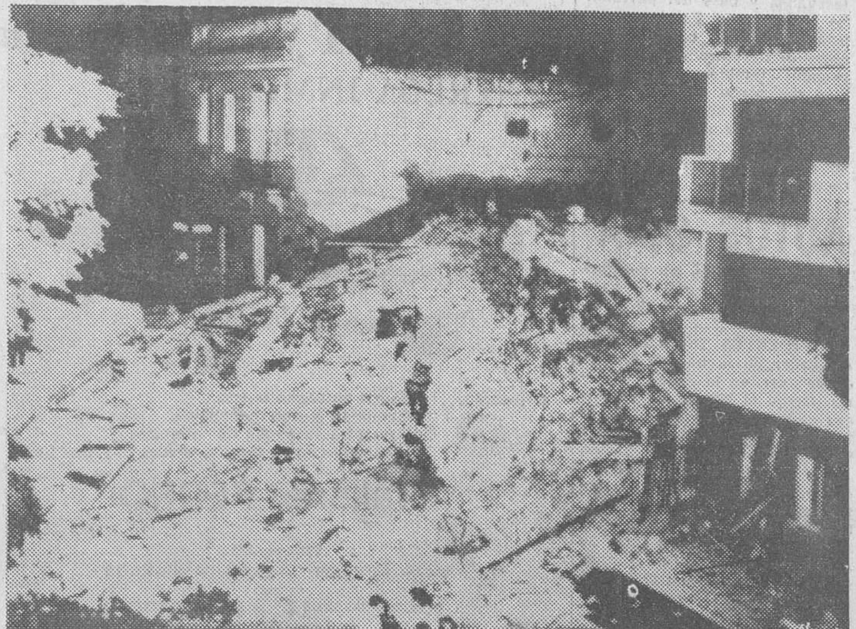
Buenos Aires. — Miembros de las brigadas de rescate trabajando en la búsqueda de posibles víctimas después del derrumbamiento de un edificio en construcción de catorce pisos. El derrumbamiento sobrevino cuando una piscina instalada en un piso alto perdió toda su agua debido a una rotura. — (Telefoto UPI-CIFRA)
