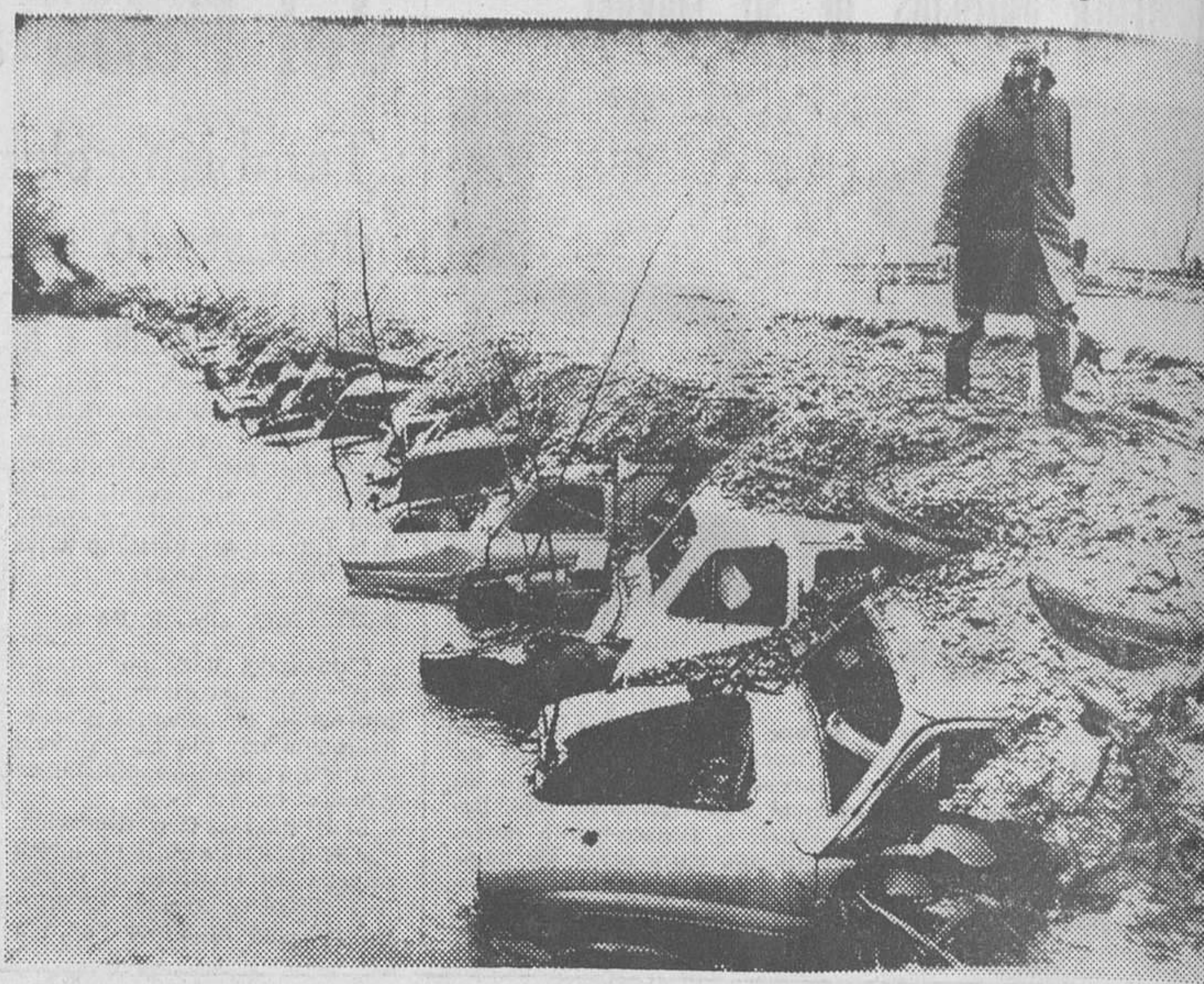
Londres. — El granjero John Williams, de Knighton, Radnorshire, ha encontrado una solución para evitar que las aguas de un río próximo a su granja destruyan las cosechas. Para lograrlo, se ha servido de restos de toda clase de vehículos, incluidos neumáticos, que ha utilizado para crear un dique artificial que, como muestra la foto, impide el acceso de las aguas del río a sus terrenos. — (Foto CIFRA GRAFICA)
