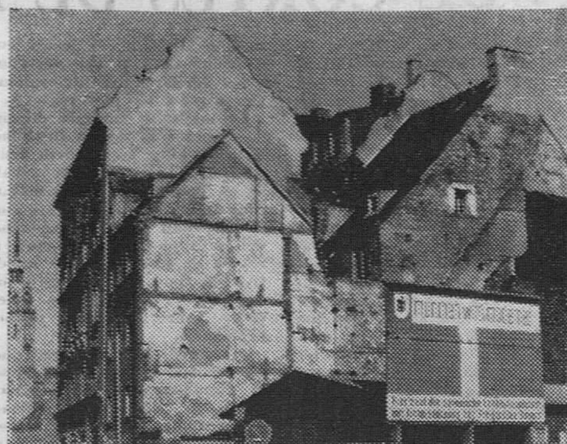
Junto a las obras de derribo de unas viejas casas de la ciudad de Munich el cartel indica que la urbe se moderniza y que en el futuro será más hermosa. Sin embargo hay quien añora la existencia de estos antiguos edificios y lamenta su destrucción. (Foto FIEL)
