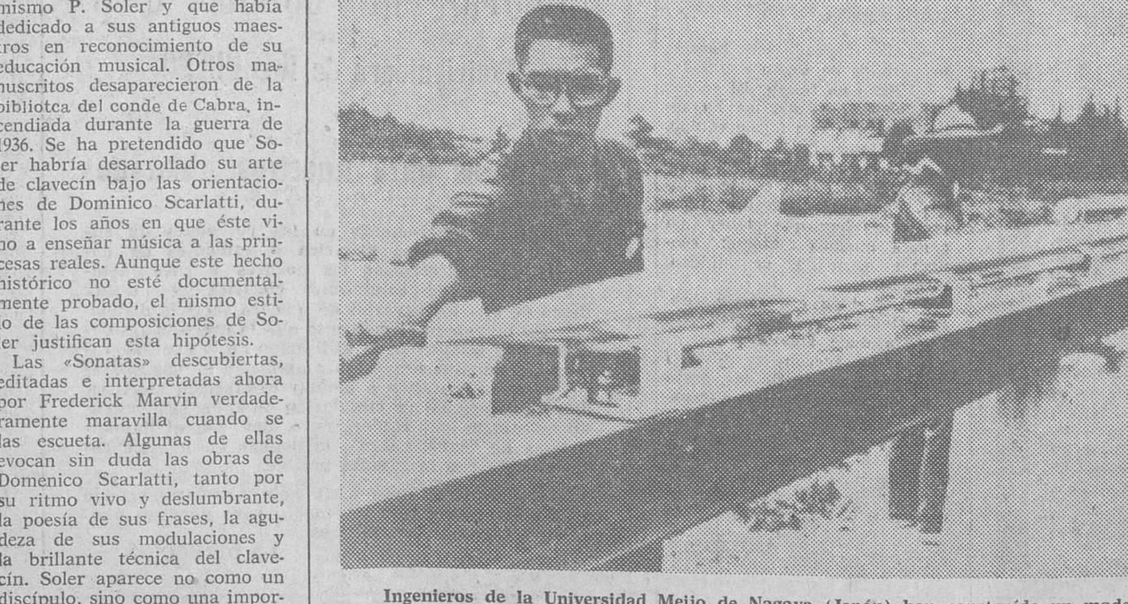
Ingenieros de la Universidad Meijo de Nagoya (Japón) han construido un modelo en tamaño reducido de un tren-cohete que marchará a una velocidad de 1.000 kilómetros por hora y que unirá las ciudades de Tokio y Osaka en 30 minutos. Será el ferrocarril más veloz del Mundo. En la fotografía vemos a los ingenieros preparando el modelo para una prueba. — (Foto FIEL).
