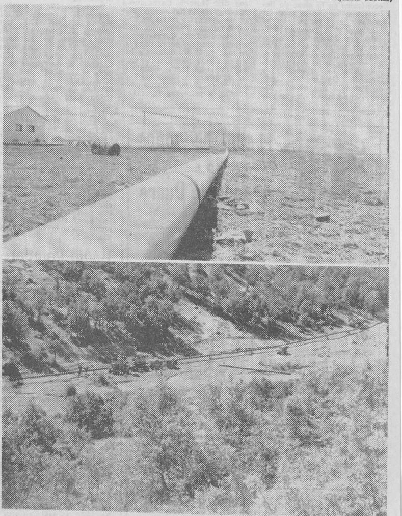
Dos vistas distintas del oleoducto que está siendo endido desde la estación receptora hasta Escalada. En primer lugar, una sección de dicho oleoducto partiendo de los mismos tanques situados en las proximidades de Sargentos y ya en dirección hacia Escalada. — (Fotos FEDE)
