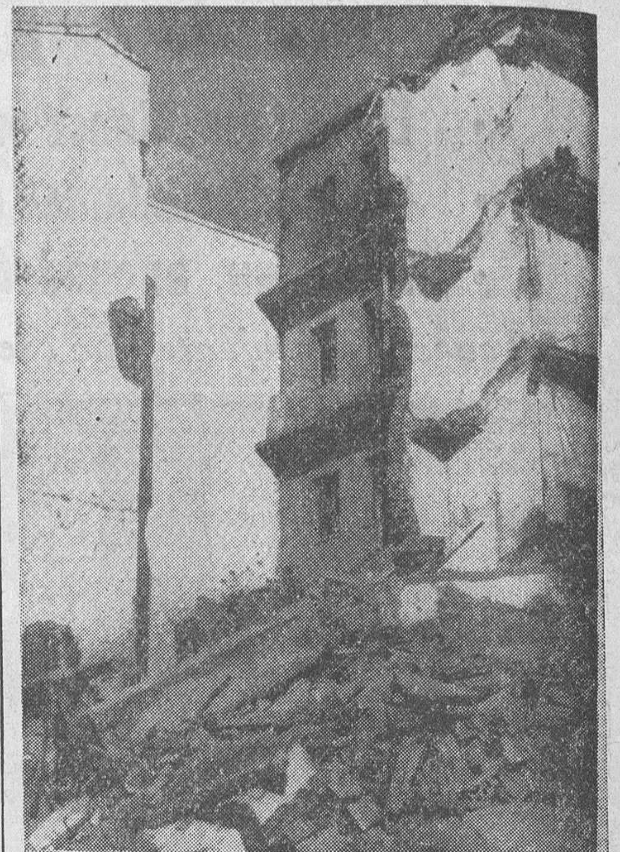
Salamanca.—Una casa de cuatro pisos, recientemente terminada, se derrumbó. Al hundirse, arrancó los balcones de las edificaciones de enfrente. Afortunadamente no hubo que lamentar desgracias personales.—(Foto Cifra)
