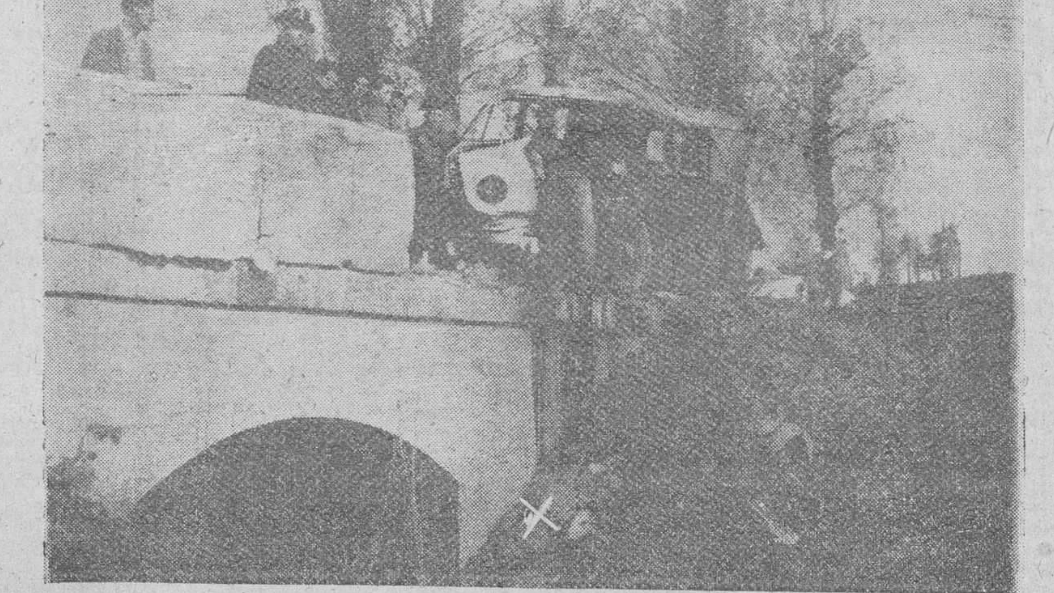
Asi quedó la furgoneta de "Almacenes Jiménez", de Burgos, después del trágico accidente sufrido el domingo último en la carretera de Madrid-Santander, a once kilómetros de Herrera de Pisuerga. Al pie del grabado y señalado con un aspa, aparece el cadáver del infortunado conductor del vehículo, don Luis Bernal, que pereció en el suceso.—(Foto A. de INES).
