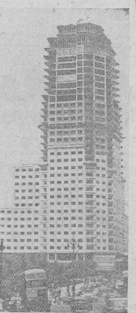
Los 120 metros de altura de la Torre de Madrid han sido rematados con la bandera nacional, símbolo de que se han cubierto las aguas del edificio. Con sus 35 plantas más dos de sótanos, 2.500 puertas y más de 1.500 ventanas, la colosal torre supera la marca mundial de estructura de hormigón armado. — (Foto Gil del Espinar)
