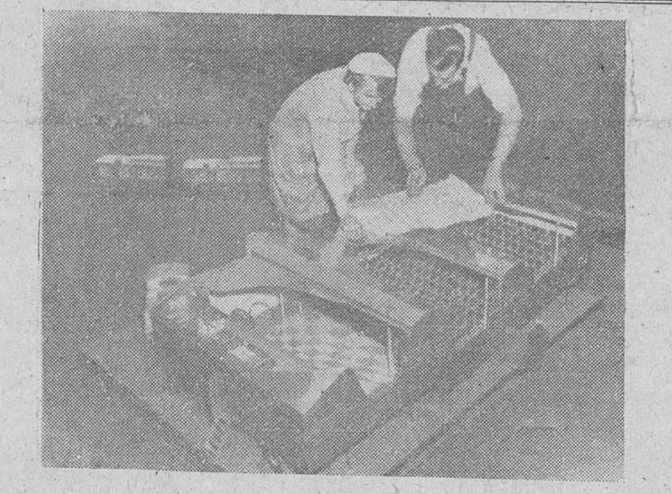
Esta es, en miniatura, la estructura del "Teatro del Siglo". Los remolques se abren para formar el techo y el piso de la sala, en la que van distribuidos 225 cómodos asientos plegables. — (Foto C.)
