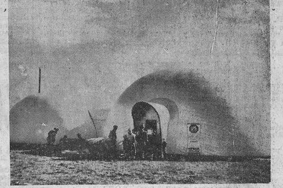
Nueva York. — He aquí el modelo de doble casa hecha de plástico y nylon y mantenida erguida a base de aire, obra del arquitecto Frank Lloyd. La estructura de la casa se compone de dos balones gigantes de 38 y 24 pies de diámetro, respectivamente, unidos por un corto túnel. La cantidad de aire inyectada para mantenerla erguida por un acondicionador es de tres toneladas, que a la vez sirve para refrigerar o calentar el interior. — (Foto Cifra)
