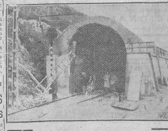
Busgondo (León). — Una de las entradas al túnel artificial de 300 metros de longitud, que actualmente se construye entre esta estación y el túnel de "La Perra", para evitar la interrupción del tráfico con Asturias, en la época invernal, a consecuencia de los temporales de nieve.—(Foto Cifra)
