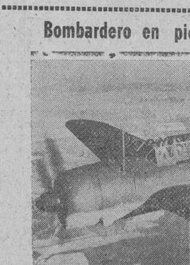
El nuevo bombardero en picado del Ejército norteamericano, A-26 durante un vuelo de prueba. Es un monoplano de ala media, provisto de un motor de 1.700 c. v. Estos aparatos fueron usados con notable éxito durante las últimas operaciones de la guerra en el Pacífico
