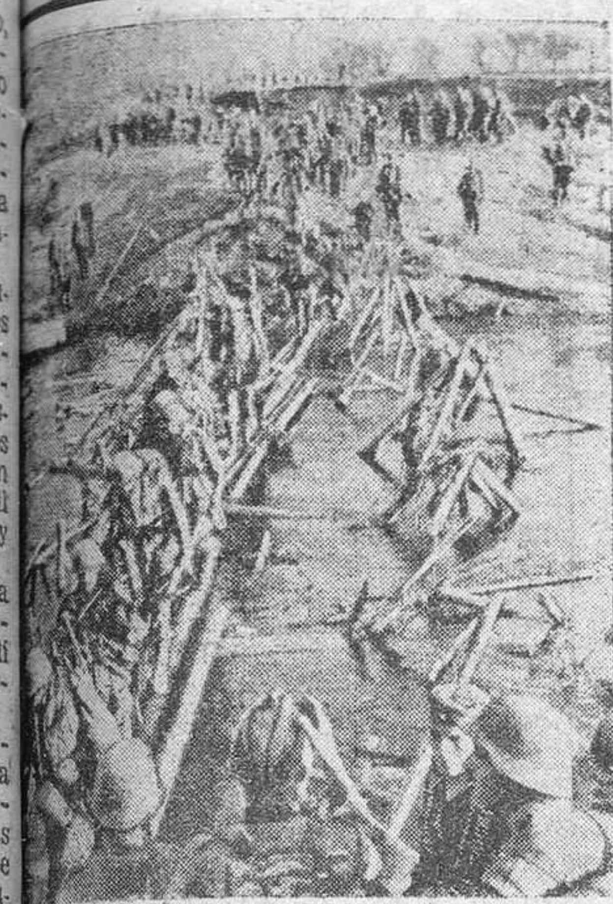
Una pasarela provisional en el frente del Este
