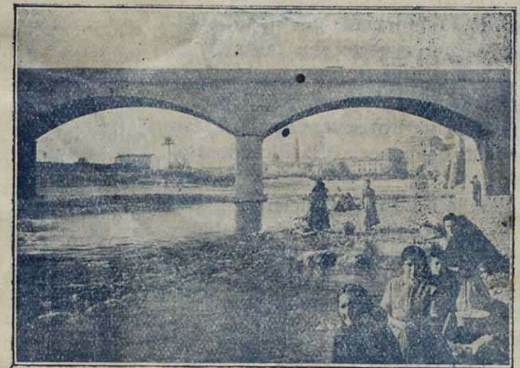
PUENTE SOBRE EL RIO SERPIS Todavía existente
