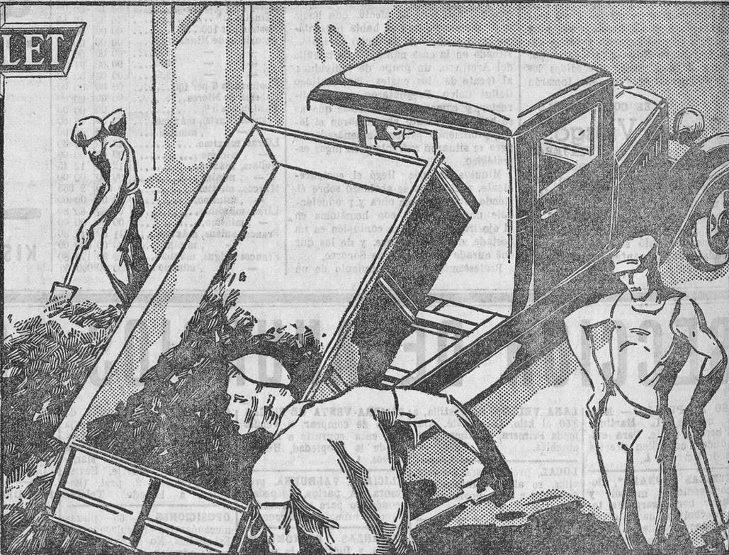
El camión Chevrolet de 3,33 mts. entre ejes, ha sido especialmente adaptado a las necesidades del transporte de materiales de construcción y está equipado con un motor Chevrolet de 53 H. P. efectivos (20 H. P. fiscales).
