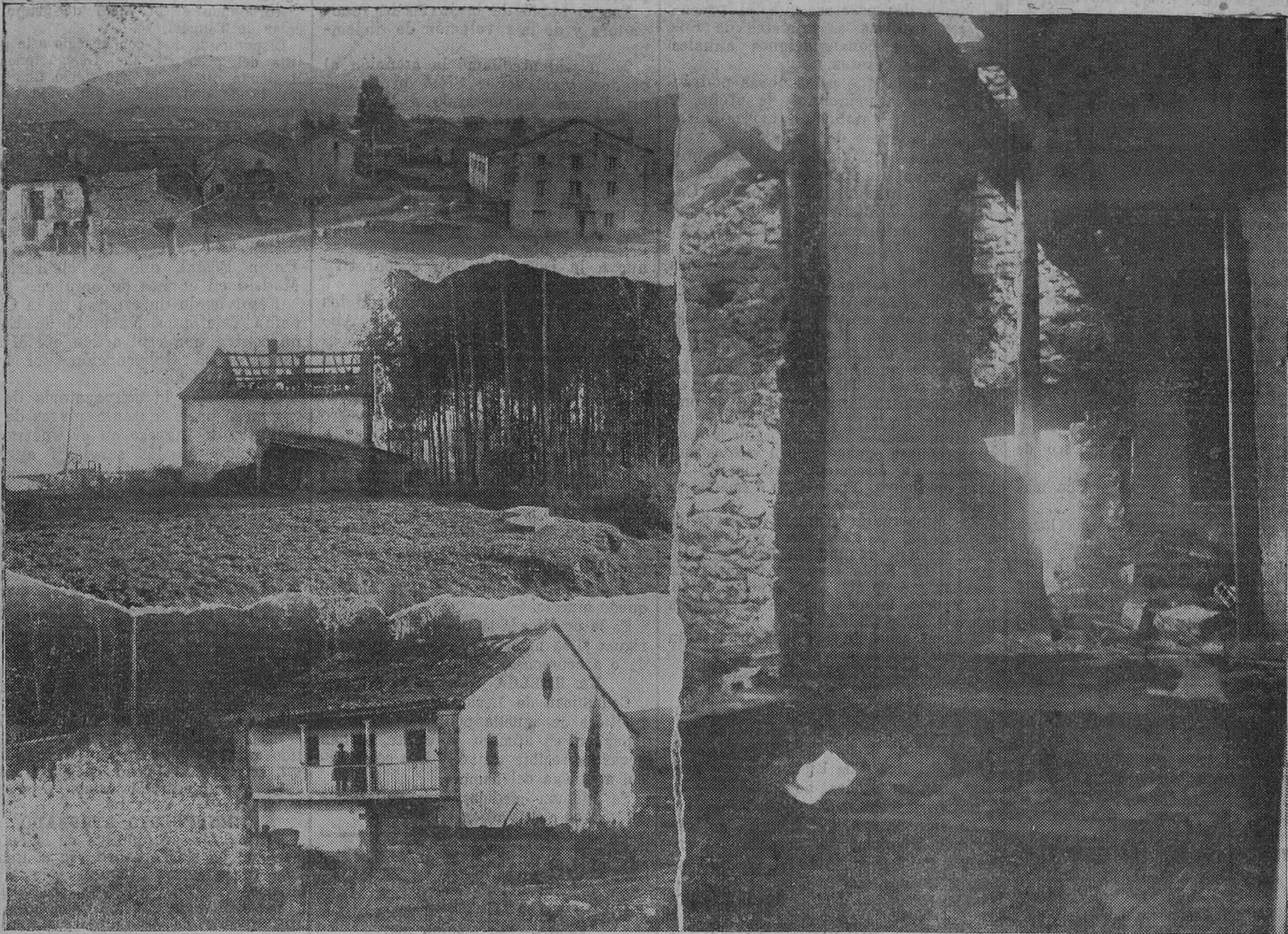
EL DRAMA DE SOBARZO. — El pintoresco pueblo donde se desarrolló el suceso. — La parte posterior de la casa y la fachada principal, por cuyo balcón fueron salvados los vecinos y retirados los heridos, con lo que se pudo evitar que perecieran entre las llamas. — La escalera de la casa donde cayeron las víctimas. En la foto se aprecian algunos impactos.
