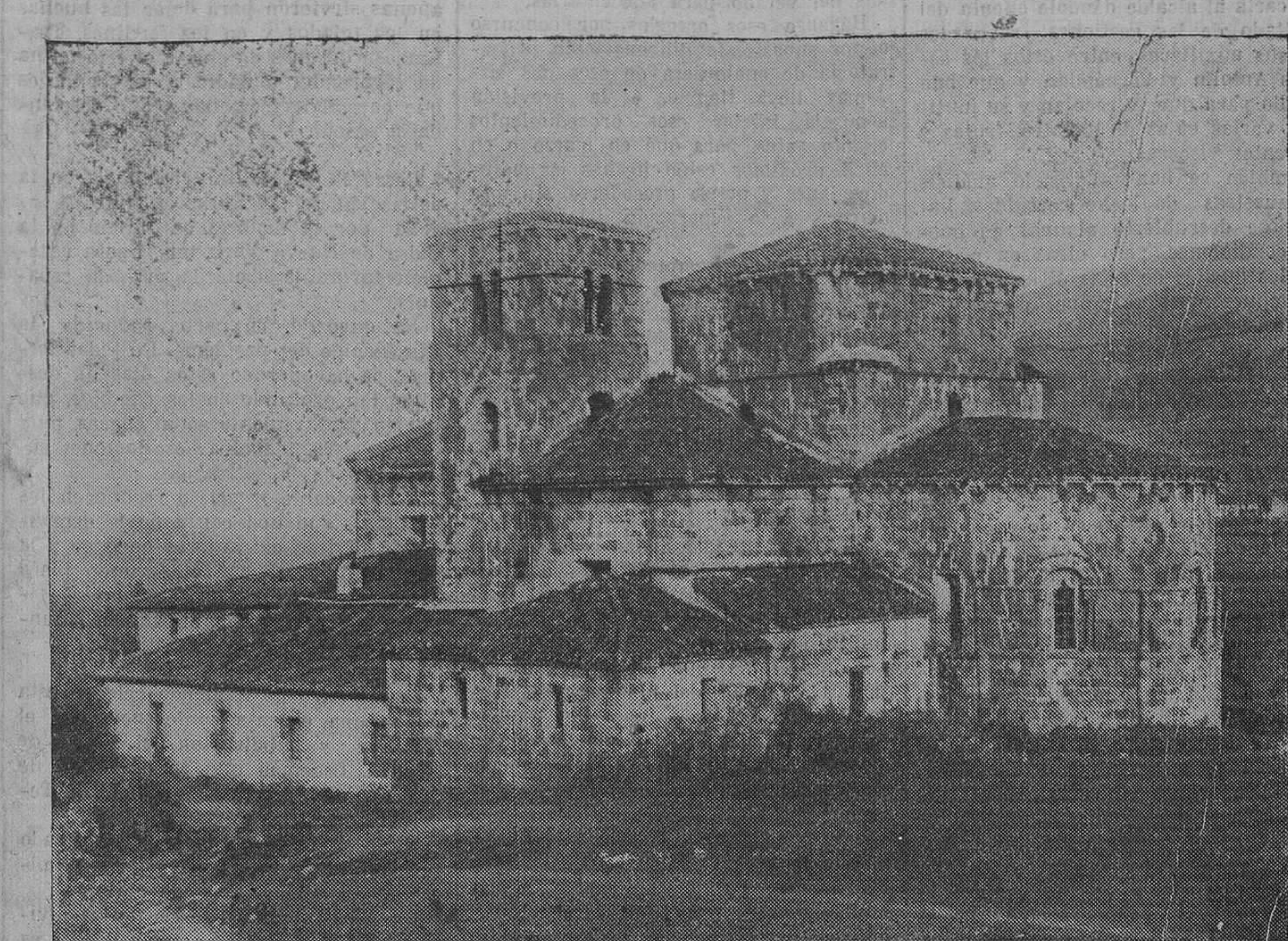
Entre las muchas bellezas arquitectónicas que guarda la Montaña, figuran las severas y magníficas colegiatas románicas como esta de Castañeda, verdadera joya de piedra a la que la pátina de los siglos ha hecho ganar en severidad y en belleza. (Foto Samot.)
