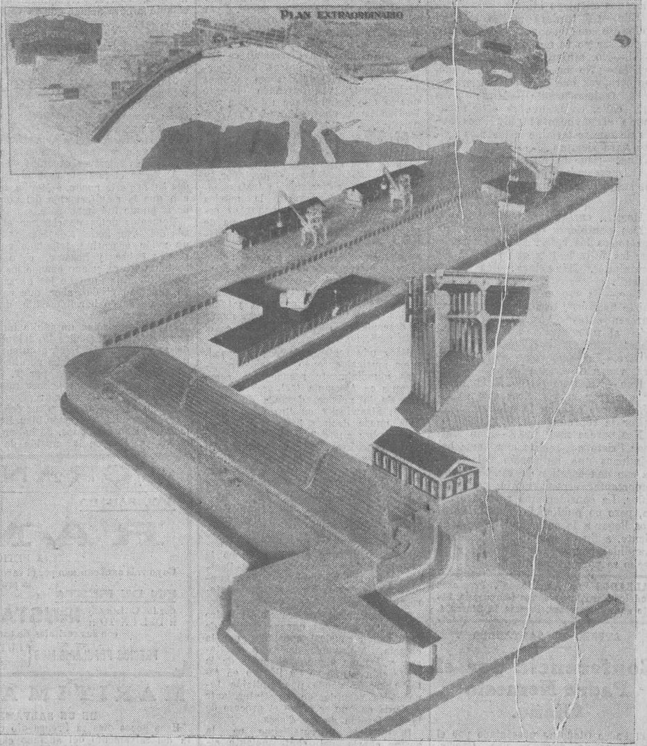
ANTAMPE. EN LA EXPOSICION DE SEVILLA. — Plano de las obras a construir por la Junta de Obras del Puerto. — M. Justas de la zona de grúas electrificadas, muelles en construcción en Maliaño, diques de Gamazo, etcétera, construidos en miniatura por dicha Junta para exhibirlos en la Exposición de Sevilla, juntamente con fotografías de diferentes asuntos del puerto. (Fotos Samol.)
