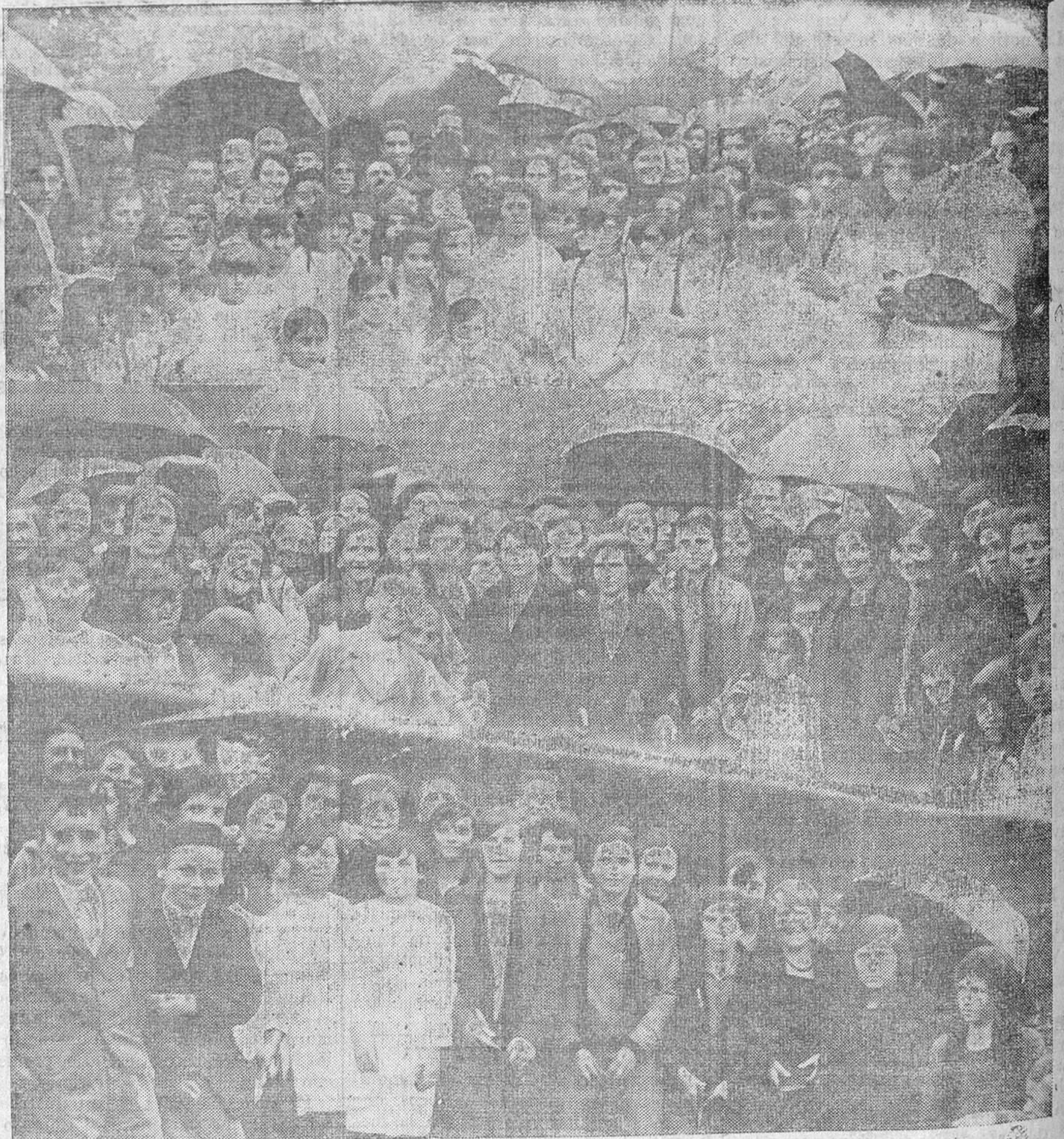
VIDIAGO.—El pueblo en masa acudió ayer, a pesar de lo inclemente del día, al acto de colocación de la primera piedra de la nueva escuela que regala al pueblo el conde del Valle de Pendueles. (Fotos Samot.)
