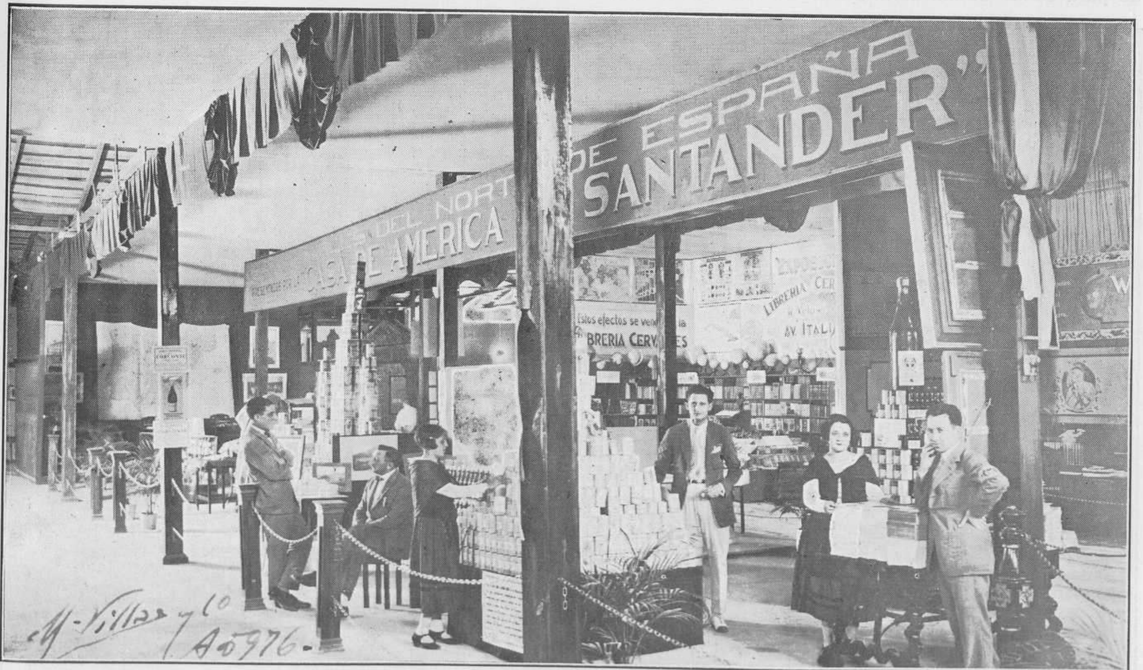
Pabellón de la "Casa de América" en la II Feria de Muestras de la Habana, donde están instalados los "stands" de los productos montañeses.
