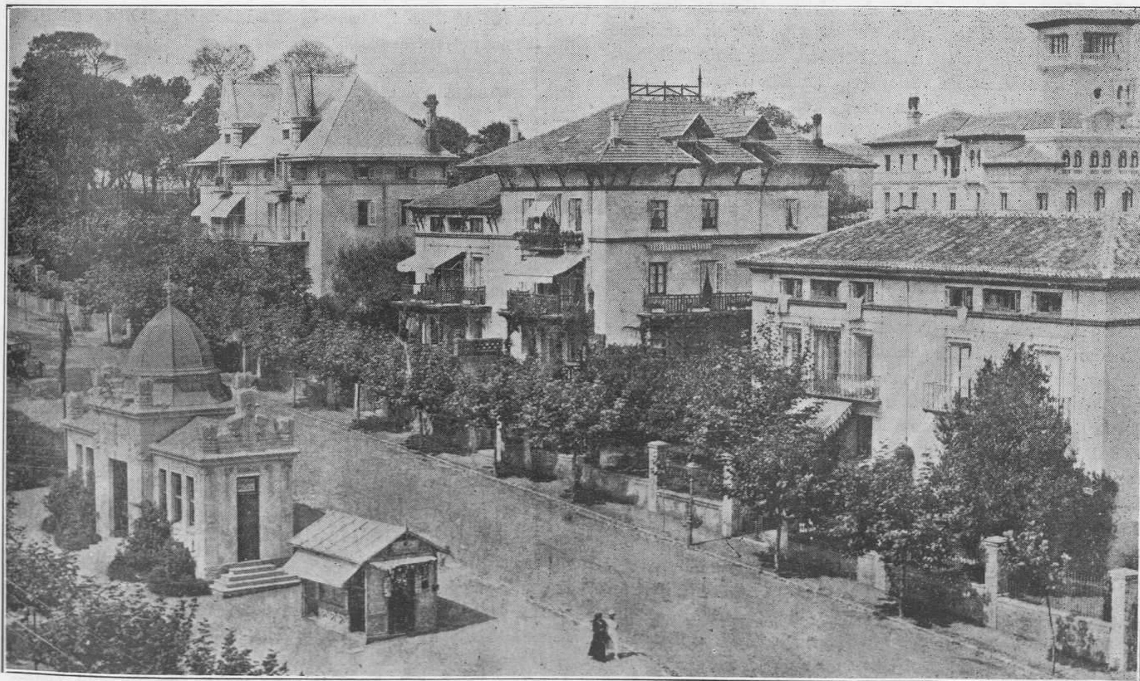
Santander.—Una vista parcial de la preciosa Avenida de los Infantes.
