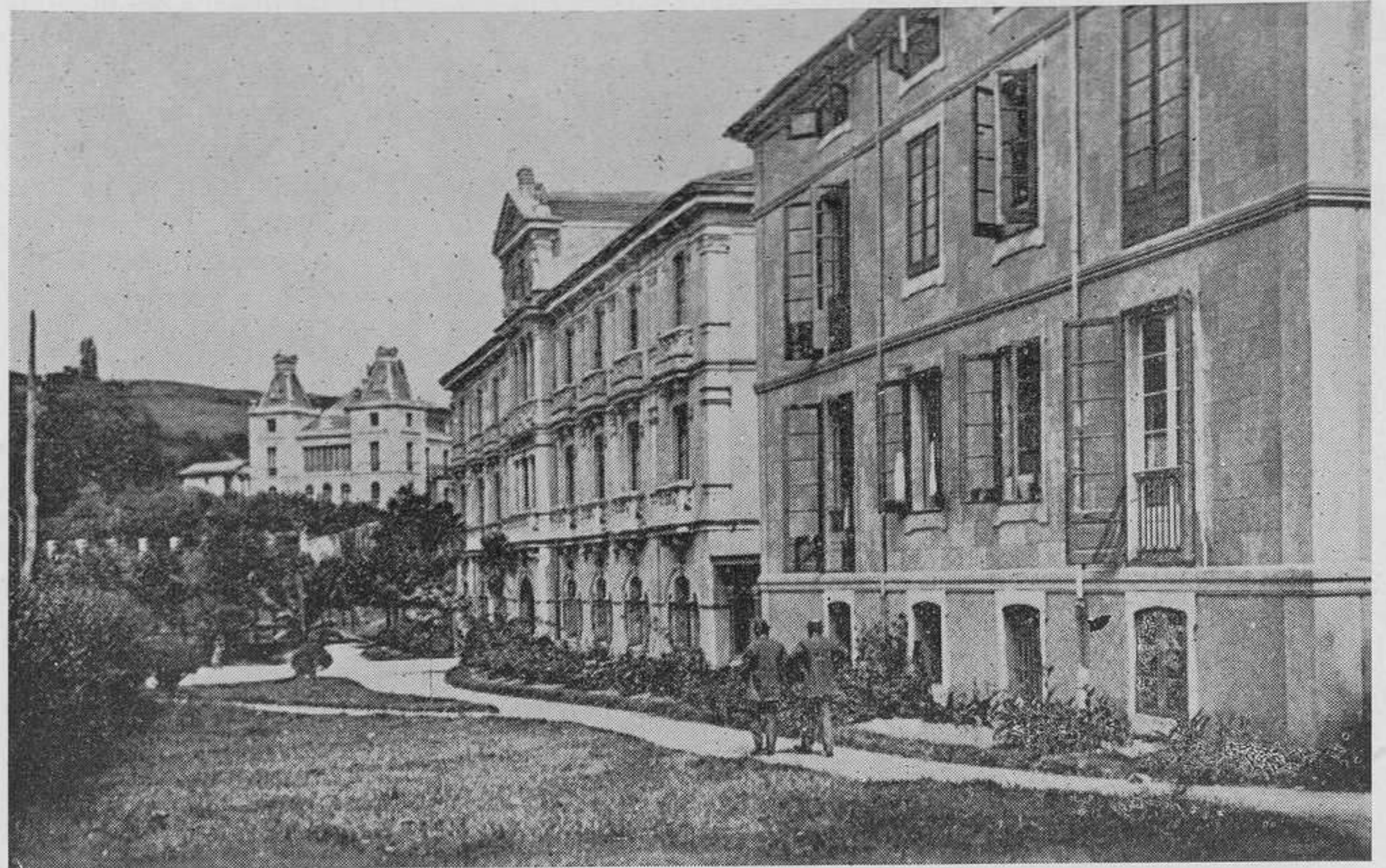
SOLARES.—Vista parcial de los hoteles y chalet "Villa Amalia".
