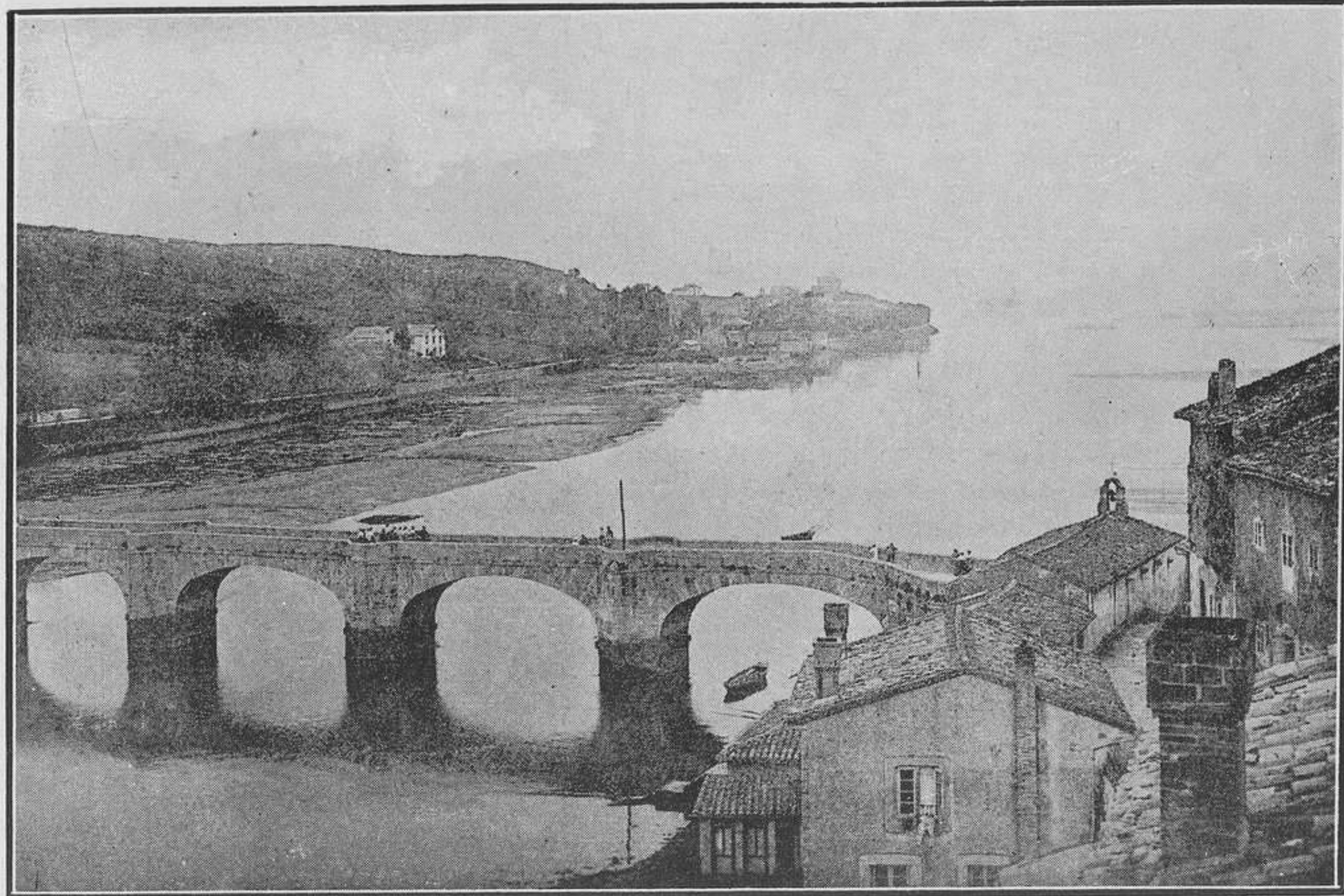
SAN VICENTE DE LA BARQUERA.—Aspecto del puente nuevo.
