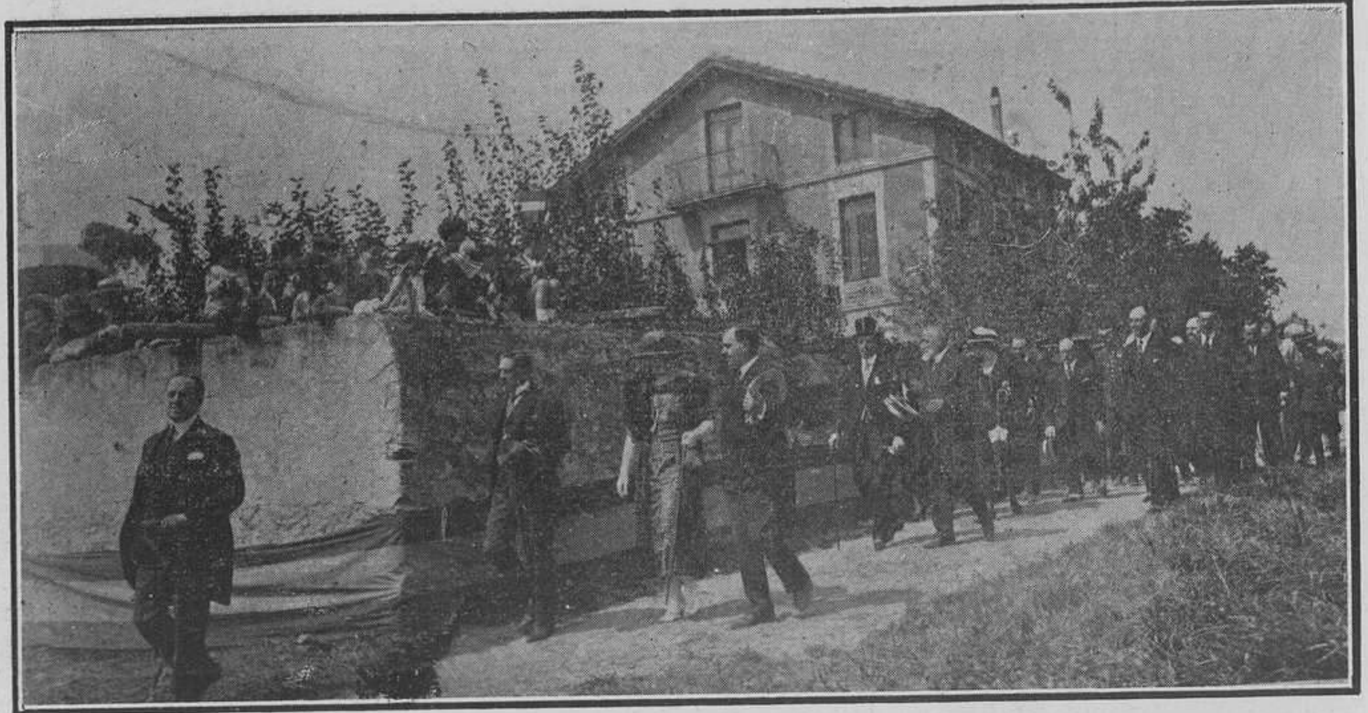
Los Reyes, al llegar a los terrenos de Villacampa, en que se edificará el nuevo Hospital.
