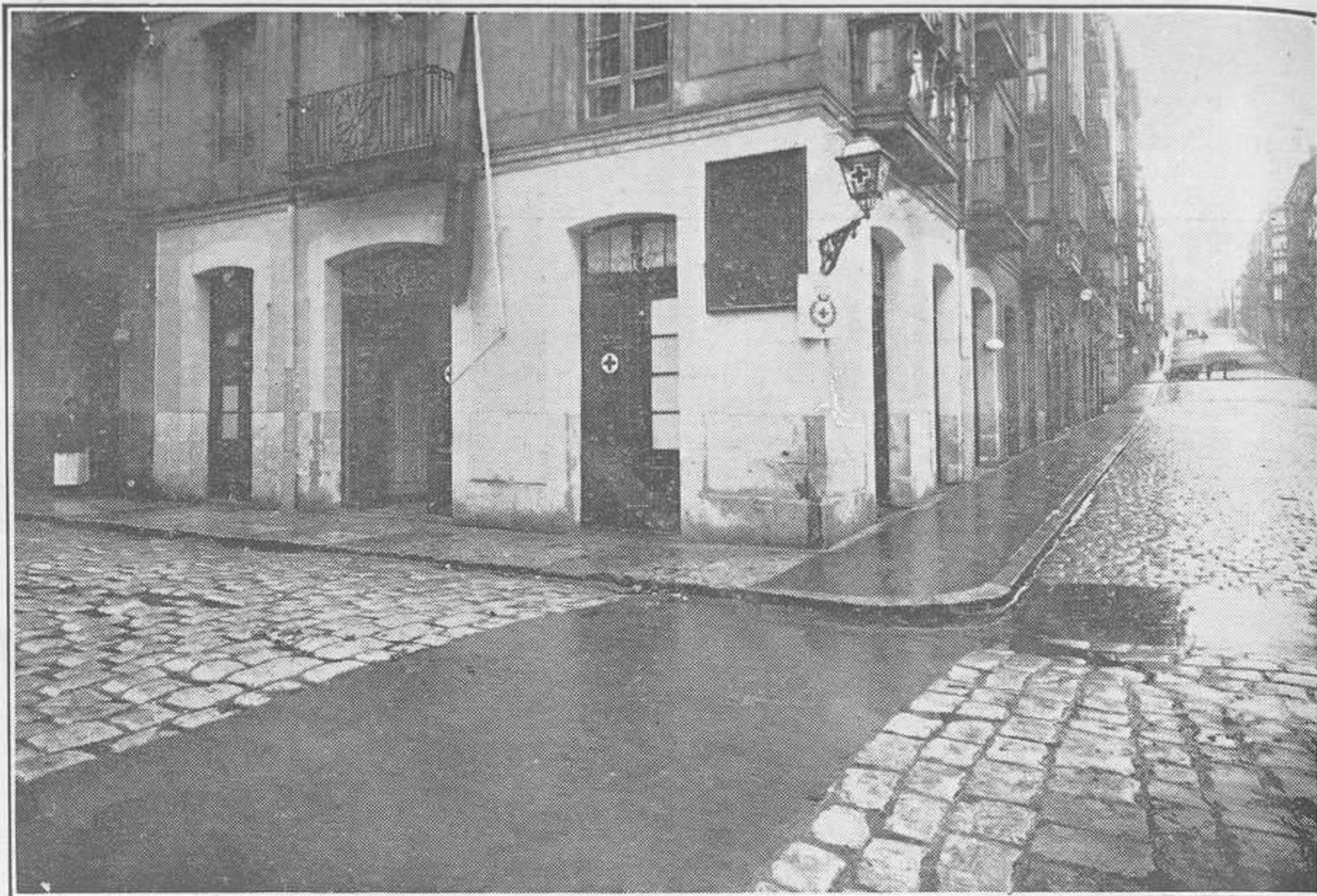
SANTANDER.—Vista exterior del edificio de la Cruz Roja.
