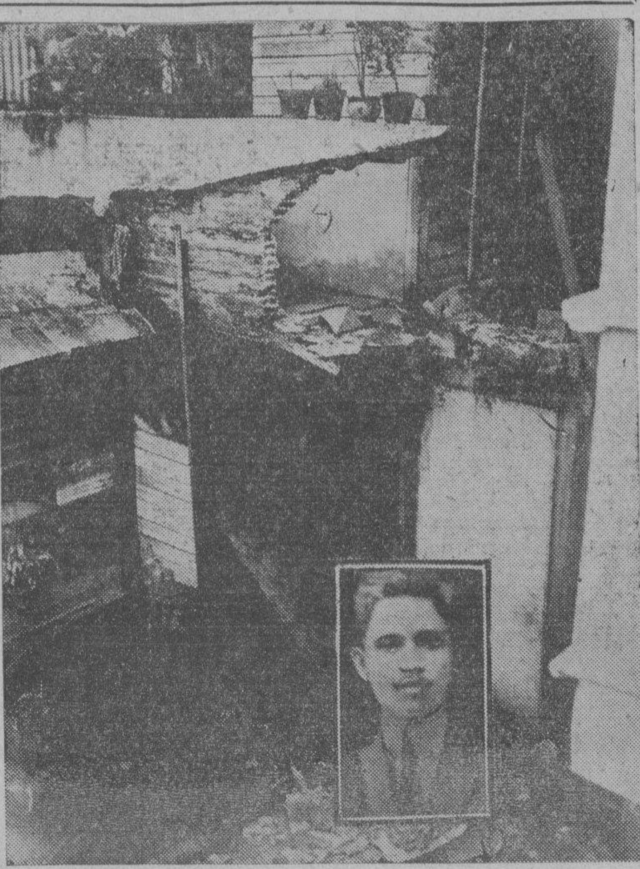
Esta es la escena de otro accidente grave en la mañana del 4 de julio, en la calle Herbosa No. 204, Tondo, que costó la vida del propietario Antonio Gutierrez. En el cliché aparece la fotografía de la azotea que se echó abajo a tiempo en que iba a ser reparado. Al desmoronarse una de las vigas cayo sobre la mesa del propietario Sr. Gutierrez, causando su muerte horas despues. En el cliché aparece tambien la fotografia del Sr. Gutierrez, de joven. Fue uno de los mas antiguos empleados de la casa Yangco.
