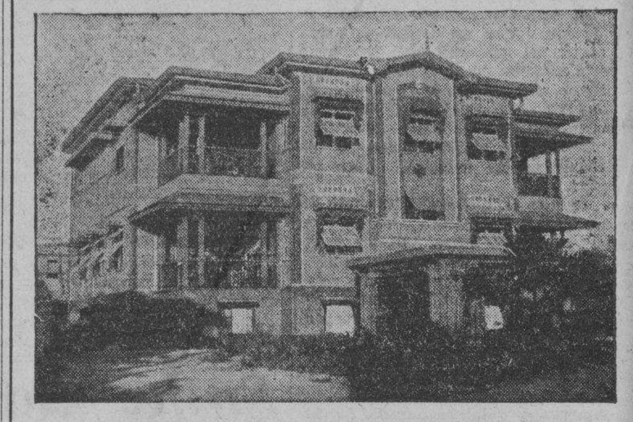
El Nuevo HARRISON HOSPITAL de Tres Pisos. Construido para el confort de muchos pacientes que piden su ingreso diariamente. Hace seis años solamente (1930) que el Dr. D. Tambatoc, que acaba de llegar de los Estados Unidos donde se especializó en Cirujía, fundó el Harrison Hospital en el antiguo edificio arrendado en F. B. Harrison a unos pocos metros de este nuevo edificio. El Dr. Tambatoc tiene la satisfacción de haber realizado en el antiguo edificio 4389 operaciones en seis años. El cree que el Harrison Hospital es popular porque todos y cada uno de estos pacientes fueron dados de alta satisfechos del buen servicio y del excelente resultado de sus operaciones. El Dr. Tambatoc continúa en el nuevo edificio con mayor capacidad, equipos modernos y mejor localización. Su salud alguna será aún más popular. El Harrison Hospital recibe cartas de todas partes de Filipinas y telefonemas de diferentes partes de la ciudad diariamente pidiendo informes sobre sus operaciones, etc. El Harrison Hospital tiene servicio gratis de ambulancia día y noche y mucho movimiento diariamente.
