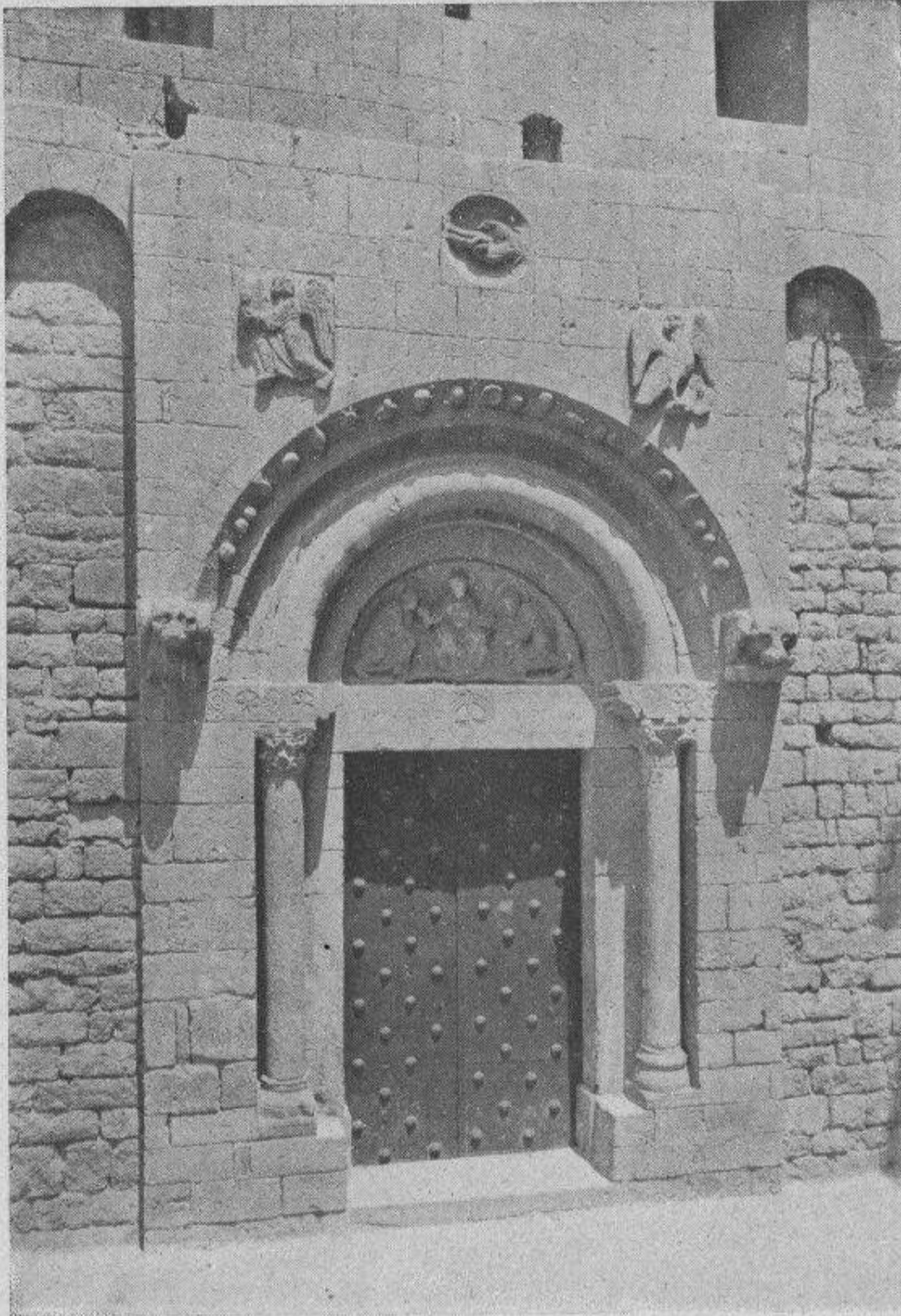
Puerta principal de entrada a la nave.
