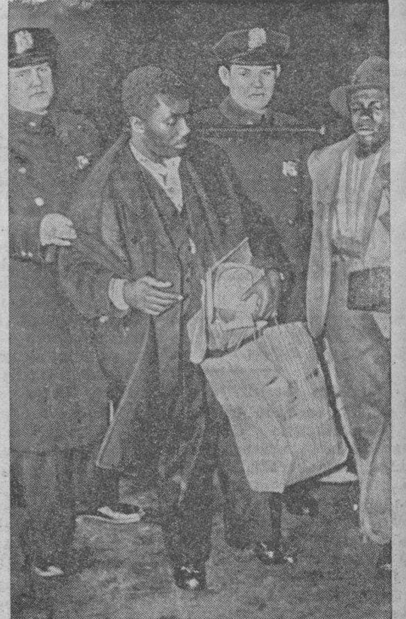
Los negros no gozan de muchas simpatías entre los americanos. Estos que aparecen en la fotografía son conducidos a la cárcel utilizando un procedimiento que deja bastante que desear.
