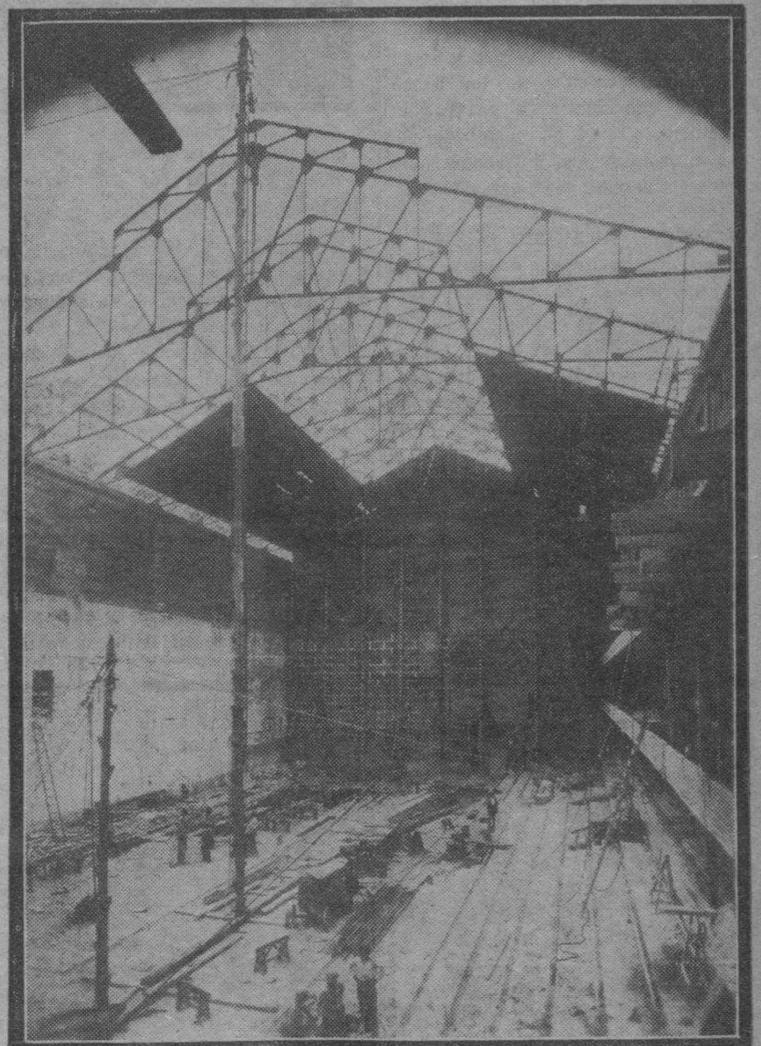
Un aspecto del frontón durante las obras, pudiendo observarse la cubierta y estructura metálica construídas en los talleres de ZARAGOZA INDUSTRIAL, S. A.
