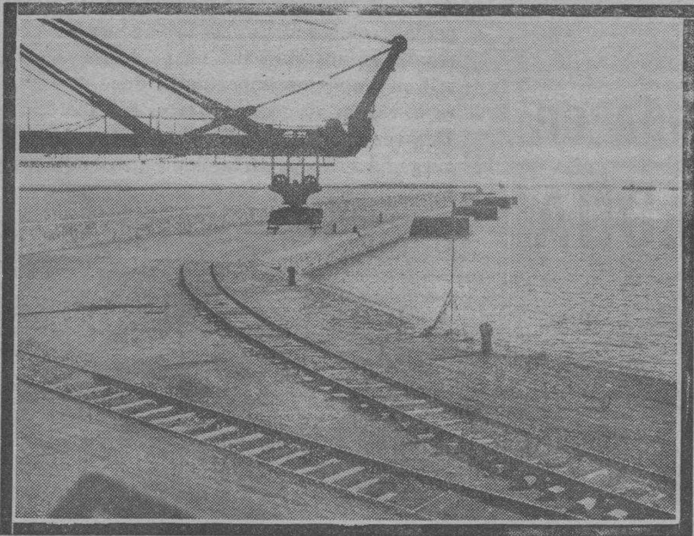
Dique-muelle de Llovera, que, junto con el espigón del mismo nombre, será el muelle de Aragón.
