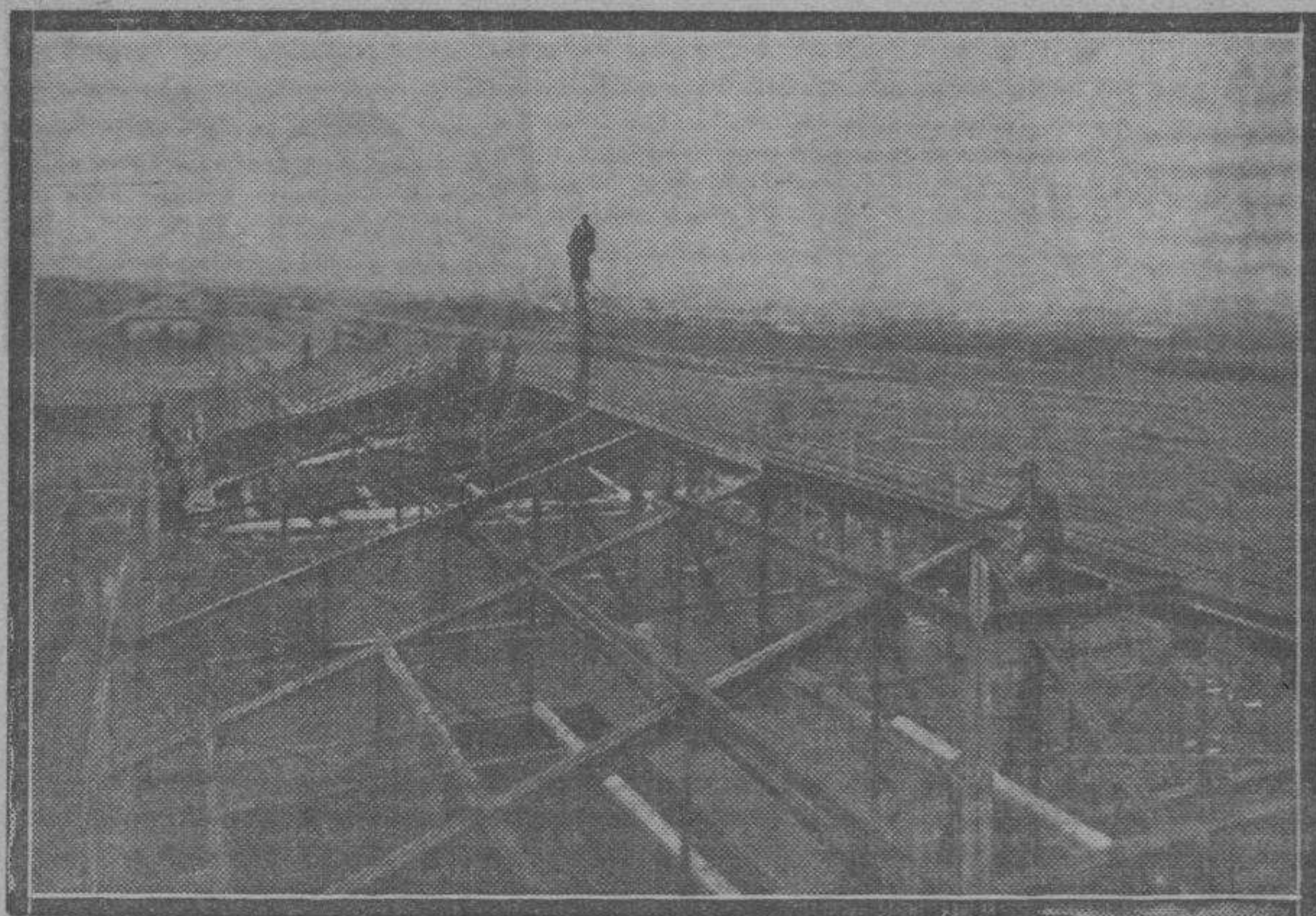
Detalle de la estructura metálica del edificio principal.
