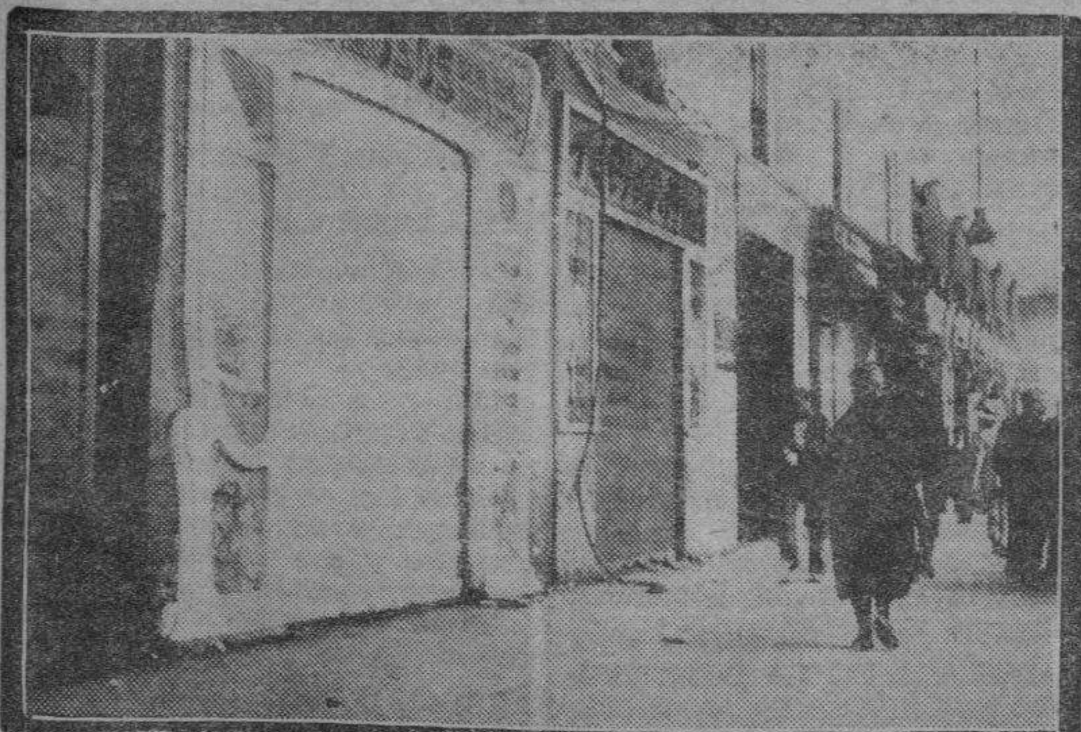
El cable telefónico que quedó reparado la tarde del lunes, junto a Tupiza, ha sido arrancado nuevamente por los grupos.
